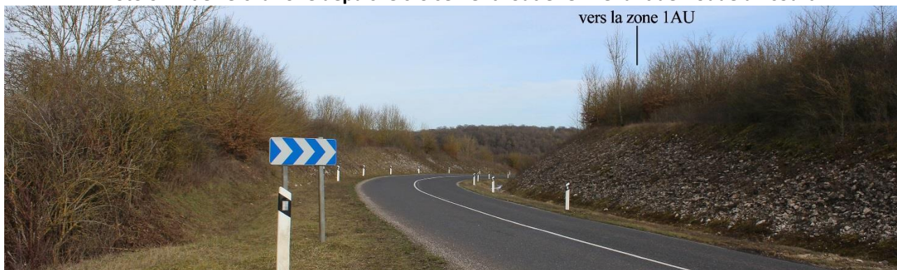
Photo 6 – Vue vers la zone depuis le croisement routier en venant de Houdelaincourt
