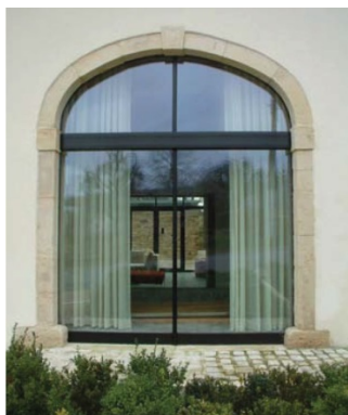
Porte vitrée - Arc cintré
