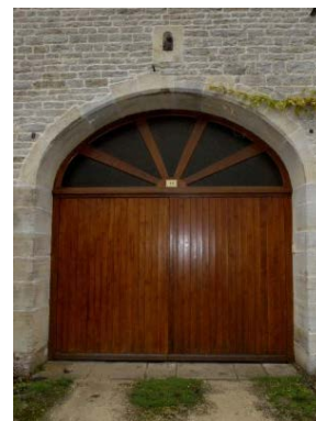
Porte pleine et imposte vitrée - Arc cintré
