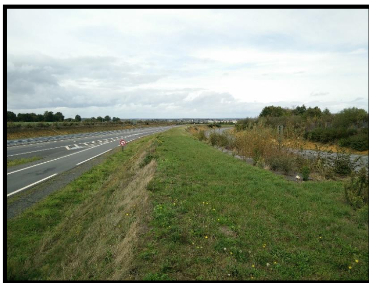
Photo n°1 – Merlon entre la RD 41 et la RD 94
