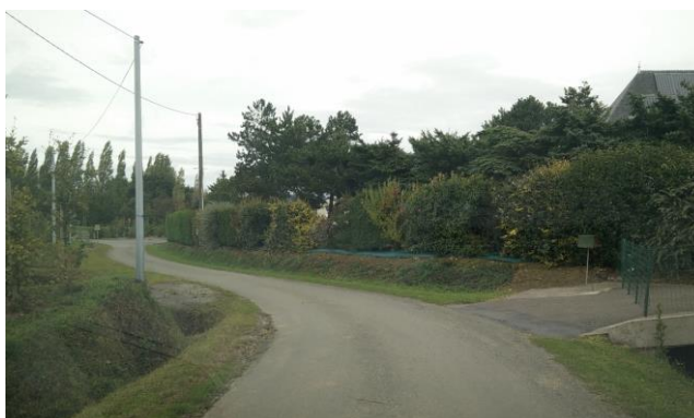
Photo n°6 – Un accès existant peu large
