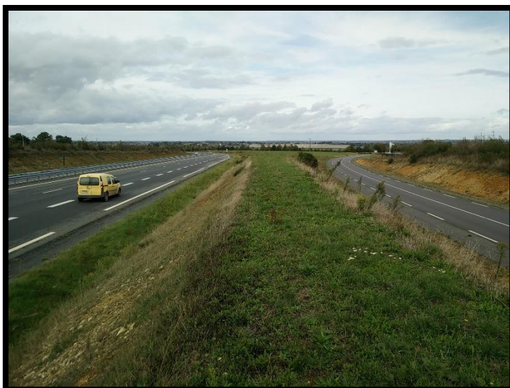
Photo n°2 – Merlon entre la RD 41 et la RD 94
