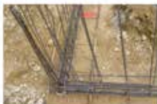
Noeud de chaînage - Continuité mécanique
