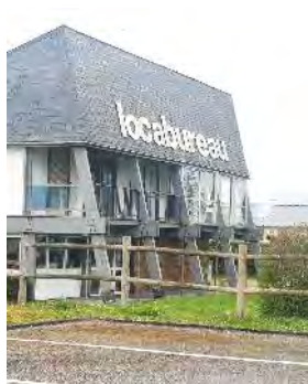
Enseigne sur toiture
