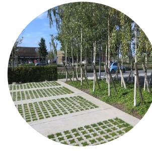
Exemple de parking semi-perméable.
