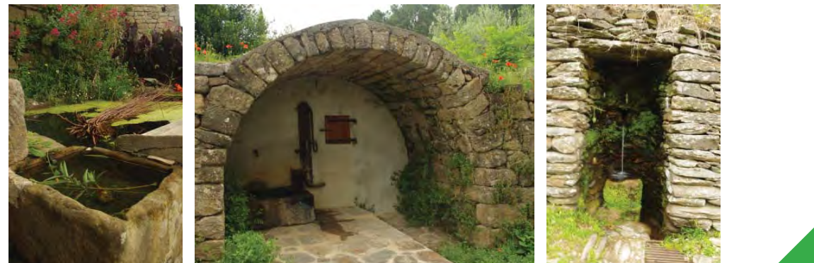
PERMANENCE DES PETITES CONSTRUCTIONS LIEES A L'EAU
