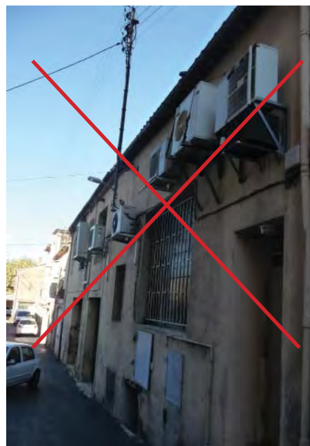
CLIMATISEUR EN APPLIQUE SUR LES FAÇADES
