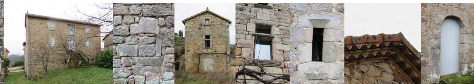
EXEMPLES D'ÉLÉMENTS ARCHITECTURAUX INTÉRESSANTS: ESCALIERS EXTÉRIEUR, TRACÉ DU PASSE, FENÊTRE À TRAVERSE, FENESTRON, PERCEMENTS, DÉBORD DE TOIT GENOISE, MENUISERIE
