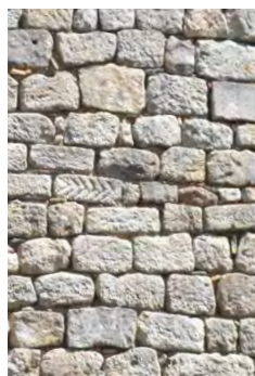
EXEMPLES D'APPAREILLAGE SERVANT DE DECOR DE FAÇADE
