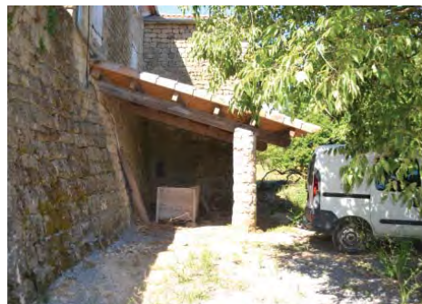
PILE EN PICODON (pierres cylindriques empilées composant le pilier)
