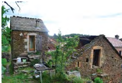
TOITURE EN LAUZE AVEC FAITAGE TRADITIONNEL
