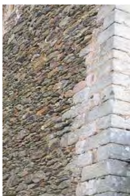
EXEMPLES DE MAÇONNERIE MIXTE: GRÈS/SCHISTE
