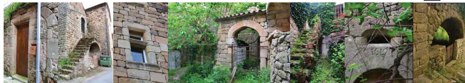
EXEMPLES D'ÉLÉMENTS ARCHITECTURAUX INTÉRESSANTS: PORTE AVEC LINTEAU EN ACCOLADE, ESCALIER EXTÉRIEUR, FENÊTRE À MENEAU, PORTAIL, CLEF AVEC MILLÉSIMÉ ET VENTILATION, BAIE BOUTIQUIÈRE
