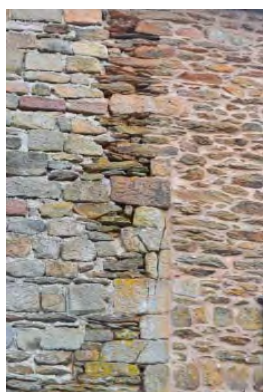
EXEMPLES DE MAÇONNERIE MIXTE: GRÈS/SCHISTE
