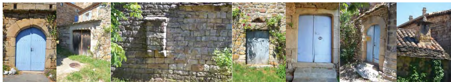
EXEMPLES D'ÉLÉMENTS ARCHITECTURAUX INTÉRESSANTS: PERCEMENTS, PORCHE ARC EN ANSE DE PANIER, LATRINES, LINTEAU DROIT, ARC DE DÉCHARGE, ENCADREMENT PIERRE, PORCHE AUVENT EN LAUZE, SOUCHE TRADITIONNELLE
