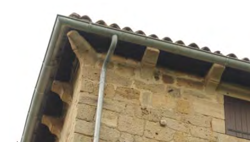
DÉBORD DE TOITURE SUPPORTÉ PAR DES CORBEAUX DE PIERRE MOULURÉE
