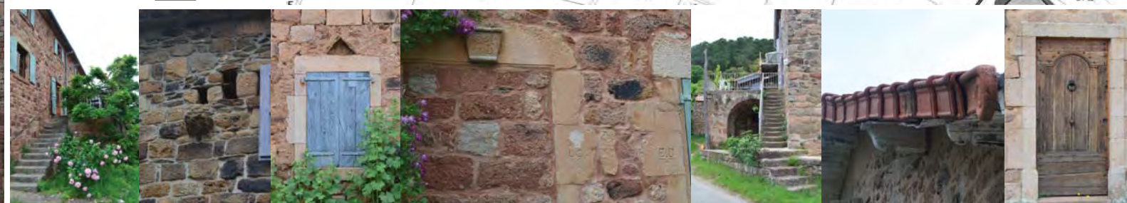
EXEMPLES D'ÉLÉMENTS ARCHITECTURAUX INTÉRESSANTS: ESCALIERS EXTÉRIEUR, PIGEONNIER SUR FAÇADE, FENÊTRE, MENUISERIE, ARC DE DÉCHARGE BAIE OBSTRUÉE, MILLÉSIME, CHEVRON MOULURE, TUILE DE RIVE
