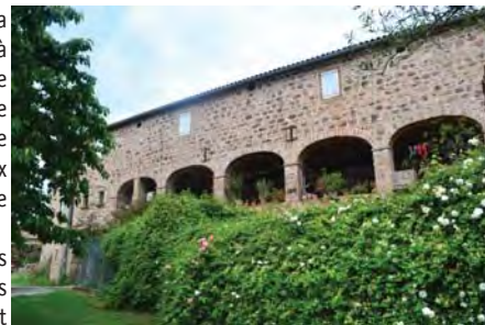
EDIFICE REMARQUABLE: ANCIENNE FILATURE MAISON A COURADOU
