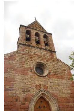
FAÇADE SUD (CLOCHER-PIGNON)
