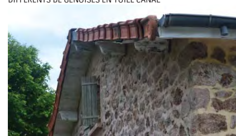
DEBORD FAUX CHEVRONS MOULURÉS, TUILES DE RIVE MOULURÉES GÉNOISE TUILES CANAL ET TUILES PLATES
