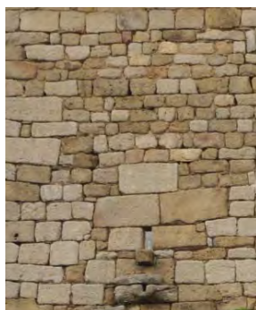
EXEMPLES D'APPAREILLAGE SERVANT DE DECOR DE FAÇADE
