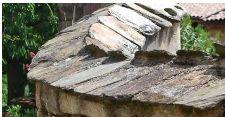
Mise en oeuvre traditionnelle des faîtages en lauze dite «en lignolet»
