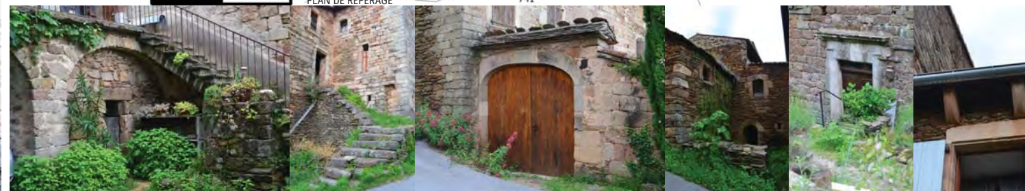
EXEMPLES D'ÉLÉMENTS ARCHITECTURAUX INTÉRESSANTS: ESCALIERS EXTÉRIEURS, PORTAIL FERMANT UNE COUR AVEC COUVERTURE EN LAUZE, BAIES ET ENCADREMENTS EN PIERRE, DÉBORD DE TOIT EN CORBEAU DE PIERRE
