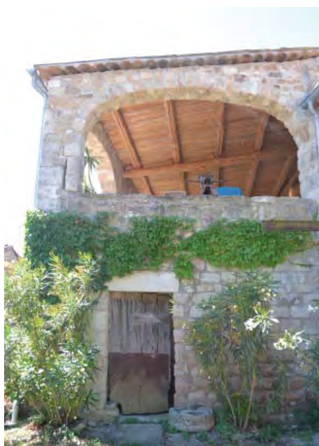
TERRASSES EN TOITURE
