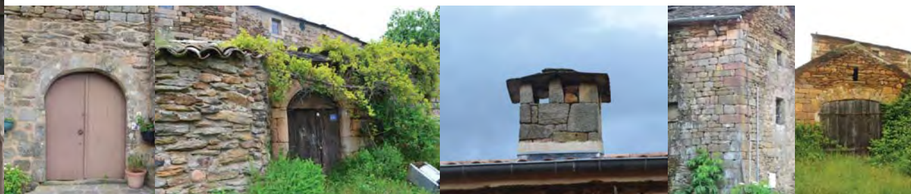
EXEMPLES D'ÉLÉMENTS ARCHITECTURAUX INTÉRESSANTS: PERCEMENT, SOUCHE TRADITIONNELLE, CHAÎNE D'ANGLE, MENUISERIE
