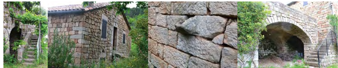
EXEMPLES D'ÉLÉMENTS ARCHITECTURAUX INTÉRESSANTS: ESCALIERS EXTÉRIEURS, ENCADREMENT DES BAIES EN PIERRE, PIERRE À ÉVIER
