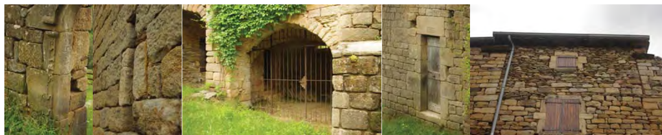
EXEMPLES D'ÉLÉMENTS ARCHITECTURAUX INTÉRESSANTS: JAMBAGE TAILLÉ, FENESTRON, GRILLE, LINTEAU DROIT AVEC MILLESIME, MENUISERIE, DEBORD DE TOITURE, CHAÎNE D'ANGLE, MIXITE DE PIERRE
