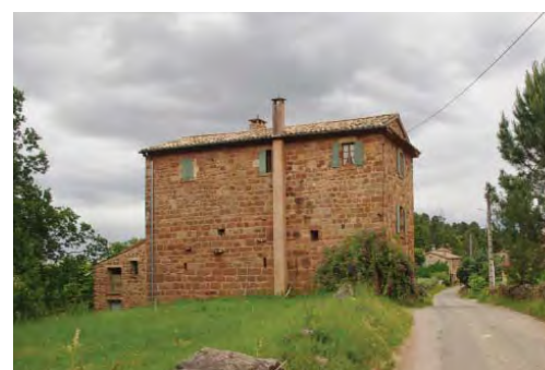
EXEMPLES DE MAGNANERIES TRANSFORMÉES EN HABITATION. ELLES POSSÈDENT DONC DE NOMBREUSES BAIES QUI ONT ÉTÉ OUVERTES QUAND LE BÂTI EST DEvenu HABITATION
