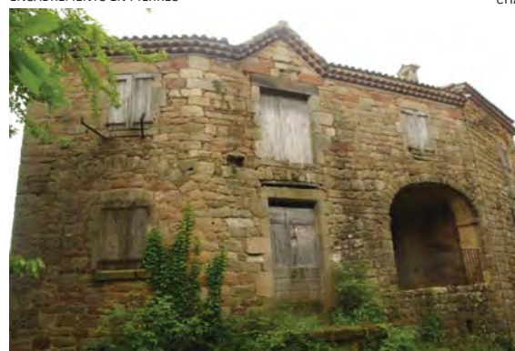
GÉNOISE ET APPAREILLAGE MUR
