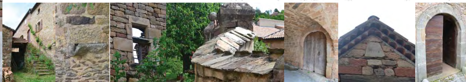
EXEMPLES D'ÉLÉMENTS ARCHITECTURAUX INTÉRESSANTS: ESCALIERS EXTÉRIEUR, PIERRE À ÉVIER, FAÏTAGE EN LAUZE «EN LIGNOLET», PERCEMENTS, DÉBORD DE TOIT EN LAUZE, MENUISERIE
