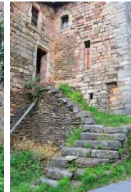
EXEMPLE DE CONSTRUCTION HYBRIDE EN GRÈS ET SCHISTES - LES ALIZIERS, BRÈS
