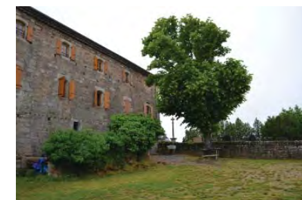
(PHOTO FAÇADE NORD)
