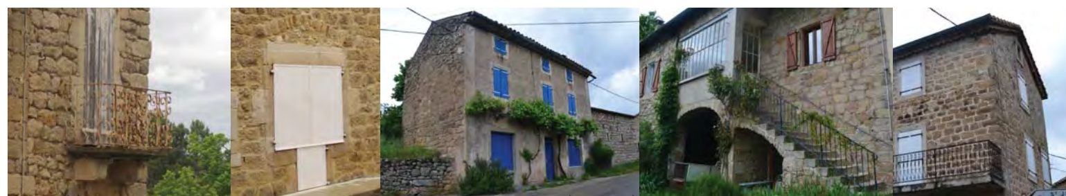
EXEMPLES D'ÉLÉMENTS ARCHITECTURAUX INTÉRESSANTS: GARDE-CORPS SERRURERIE, CORBEAU EN PIERRE, BAIE BOUTIQUIÈRE, ARC DE DÉCHARGE, ENDUIT, PERCEMENTS, ESCALIER EXTÉRIEUR, CHAÎNE D'ANGLE
