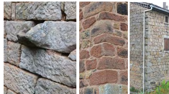
EXEMPLES DE MAÇONNERIE : UN APPAREILLAGE DÉCORATIF
