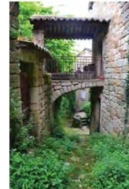
EXEMPLE DE CALADE À REVALORISER - LES CHANELS
