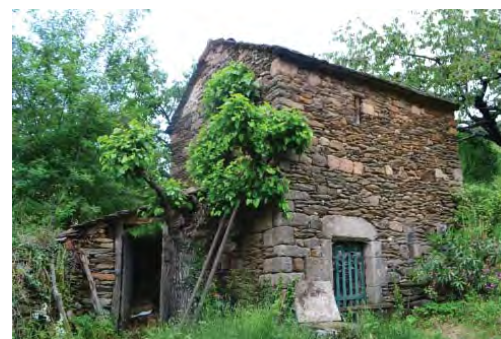
EXEMPLES DE CLÈDES TRANSFORMÉES EN HABITATION. ELLES POSSÈDENT DONC DE NOMBREUSES BAIES QUI ONT ÉTÉ OUVERTES QUAND LE BÂTI EST DEvenu HABITATION
