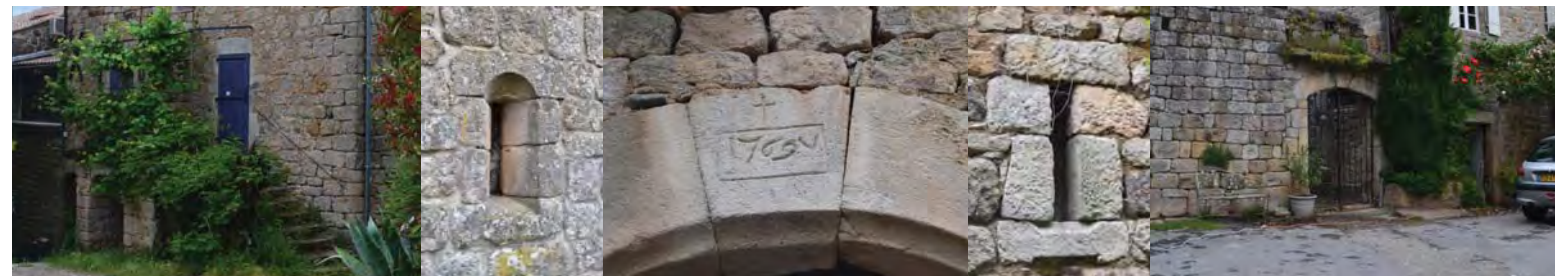
EXEMPLES D'ÉLÉMENTS ARCHITECTURAUX INTÉRESSANTS: ESCALIER EXTÉRIEUR, PERCEMENT: PORTAIL, FENESTRON, PORCHE, ENCADREMENT EN PIERRE, MILLÉSIME
