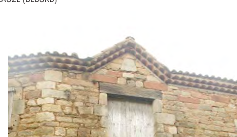
DIFFÉRENTS DE GÉNOISES EN TUILE CANAL
