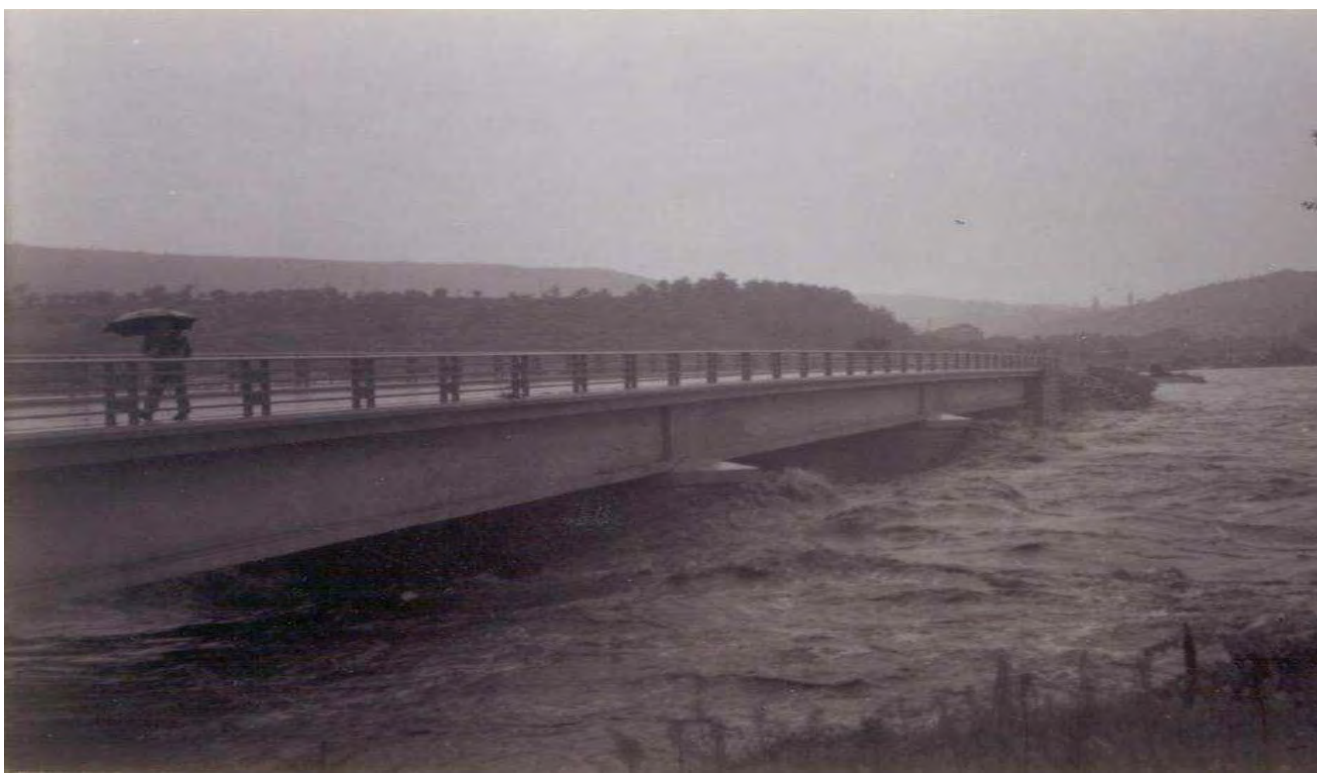
Crue octobre 1958 - amont pont de la Beaume
