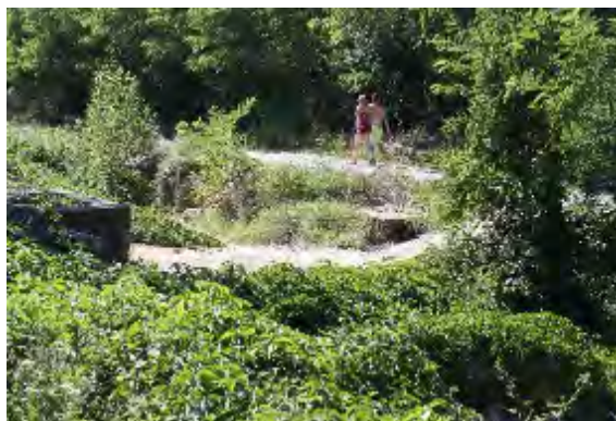
Aval du passage submersible ORI01
