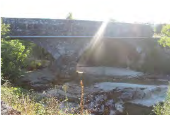
Aval de l'ouvrage CHE04
