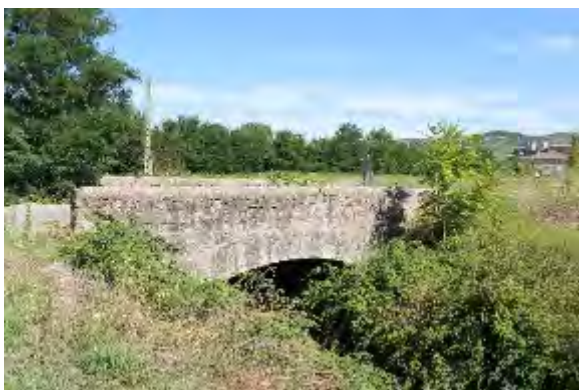
Amont de l'ouvrage ORI02
