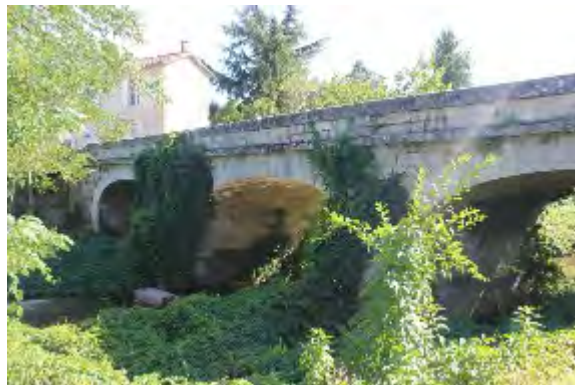
Aval de l'ouvrage AUZ04
