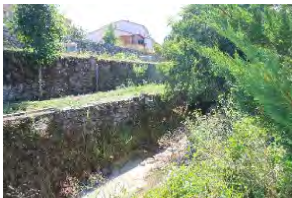
Lit mineur en amont de l'ouvrage ORI02
