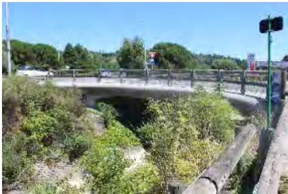
Amont de l'ouvrage CHE03
