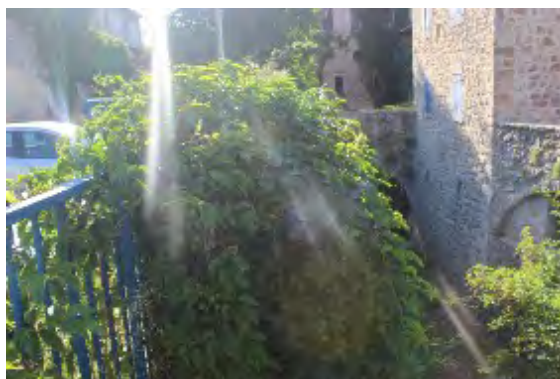
Aval de l'ouvrage BOY06
