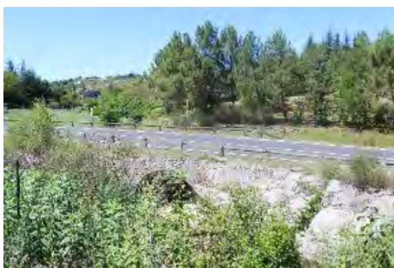
Confluence avec la Cheyette – Ouvrage BOY01
