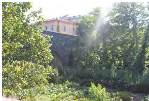
Aval de l'ouvrage AUZ05 – Vallée profonde
