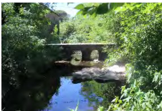
Lit mineur de la Cheysette à l'aval – Aval de l'ouvrage CHE01
