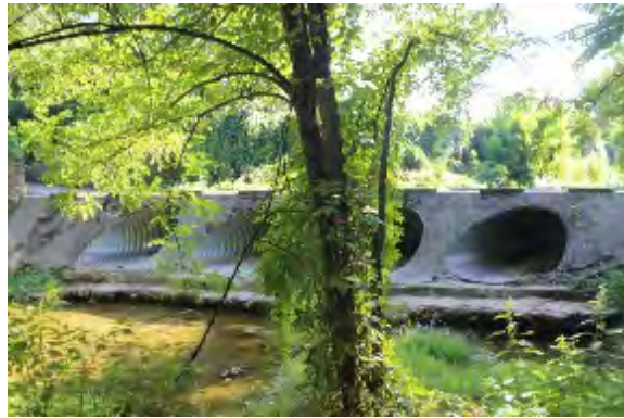
Aval de l'ouvrage AUZ02
