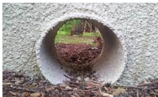
Aménagements d'ouvertures en pied de muret
