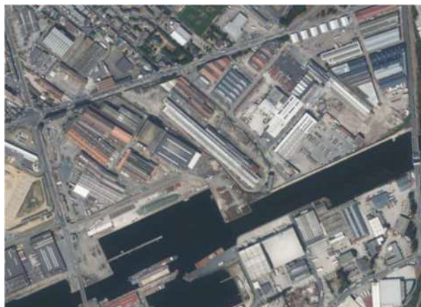
Photo aérienne (Source : TEREVAL)
