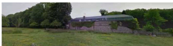
Vue depuis la rue du 11 novembre 1918 (Source : Google Street View)
