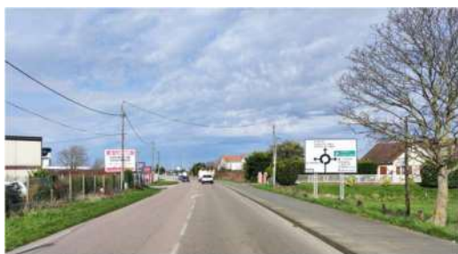
Vue dans la rue Louis Blériot (Source : OAP sectorielles du PLUi)
