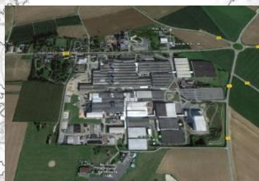
Site Bonduelle, Estrées-Mons, classé SEVESO seuil bas
