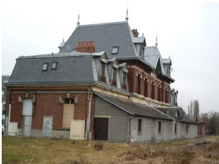
Patrimoine ferroviaire : ancienne gare de Péronne
