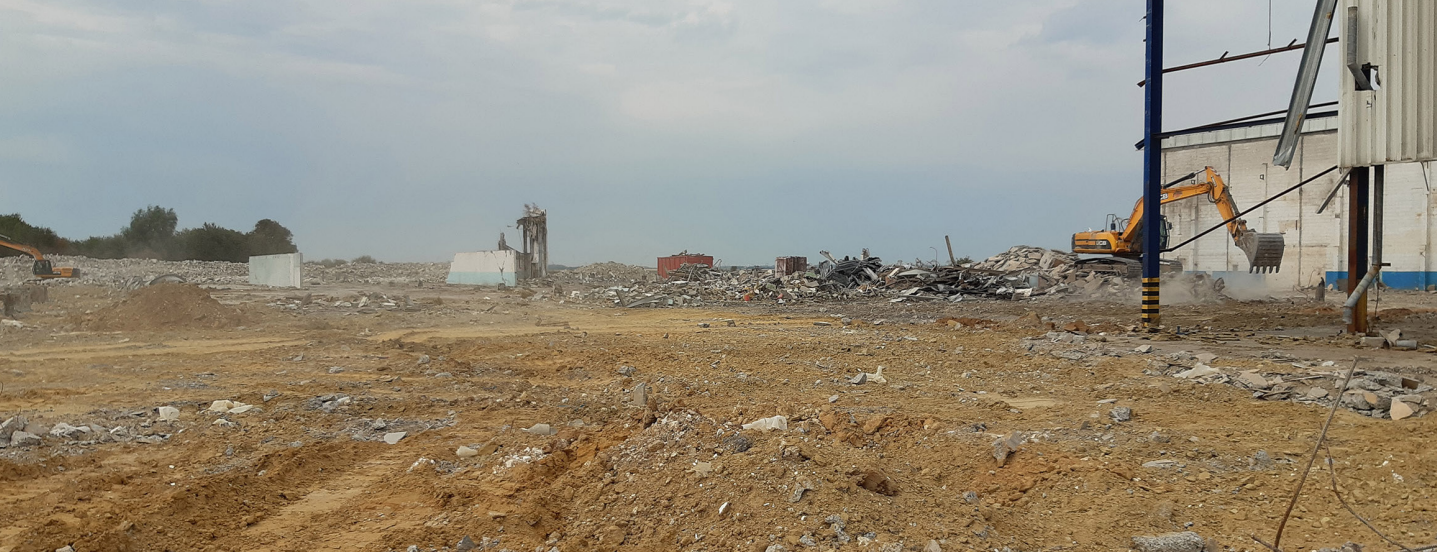
Site FLODOR en phase de démolition, octobre 2020
