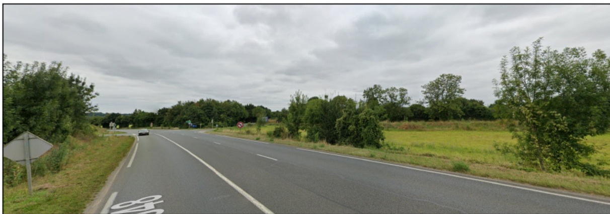
Vue depuis la RD, vers le sud
