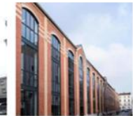
Ancienne usine Faisol aux Buis
