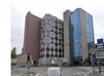
Ancien immeuble France Télécom à Bagnolet
