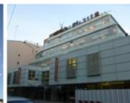
Immeuble Hermès à Pantin
