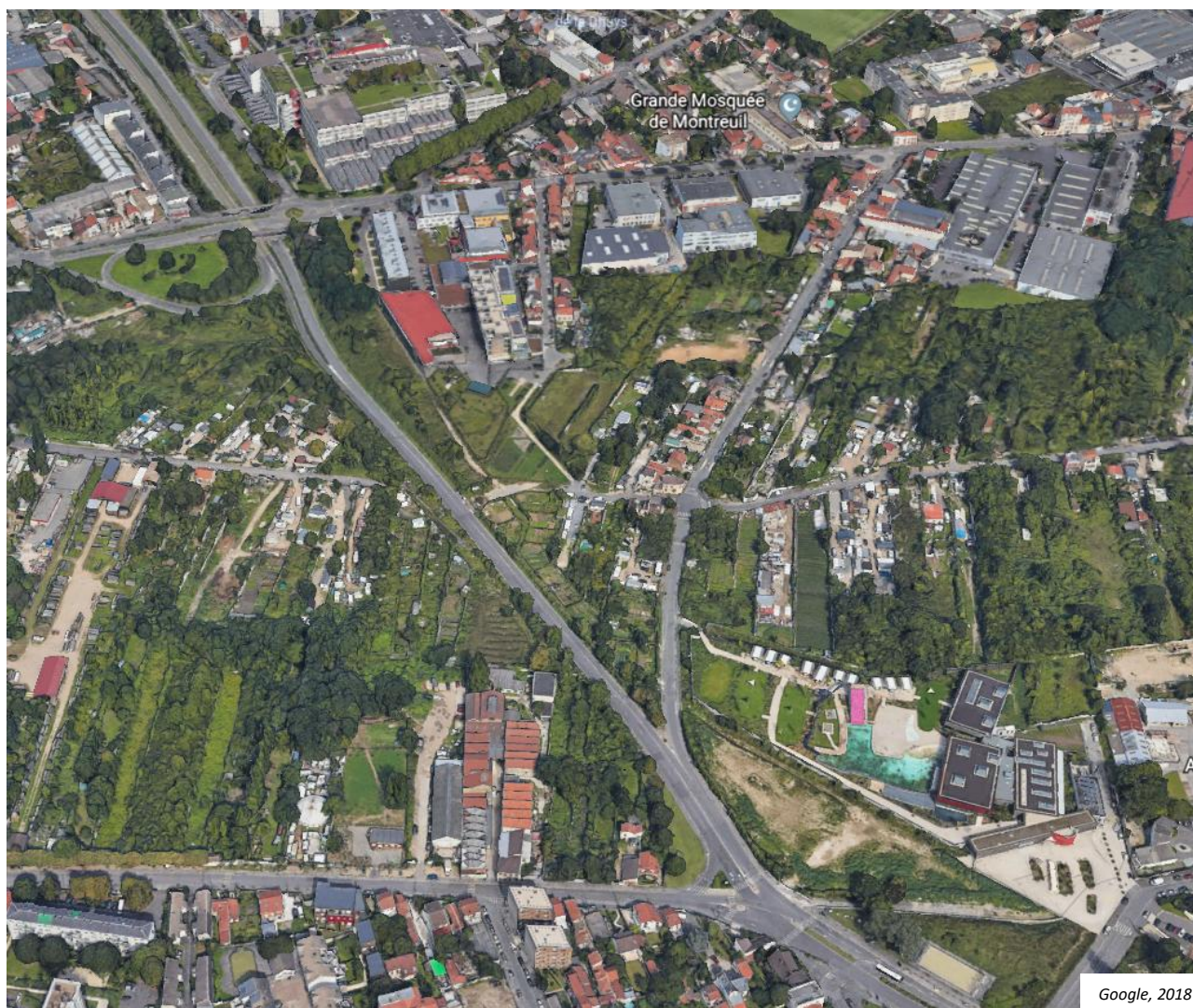
Vue aérienne du site aujourd'hui
