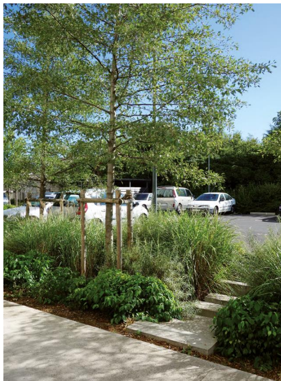
Figure 27 : A gauche : place yitzhak rabin-yasser arafat, Bobigny. Les bordures interrompues (à gauche) permettent l'écoulement des eaux de pluie vers l'espace vert et la noue (à droite).
