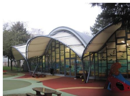
Crèche des Courtilières à Pantin
