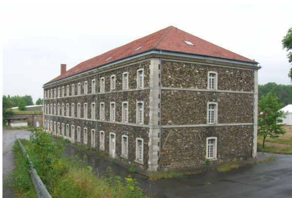
Bâtiment du fort de Romainville aux Lilas
