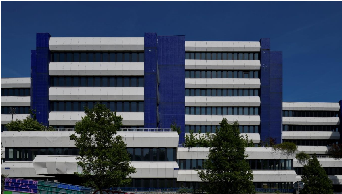
Immeuble Parmentier à Bagnolet
