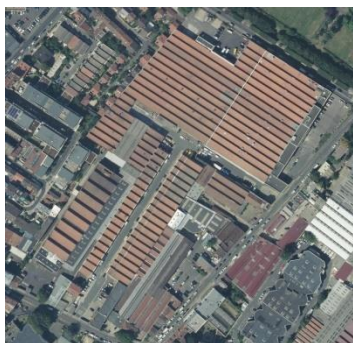
Ensemble rue Cartier-Bresson à Pantin
