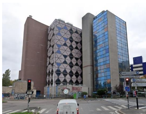
Ancien immeuble France Télécom à Bagnolet
