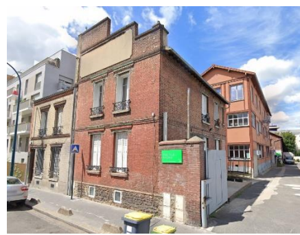
Atelier rue Méhul à Pantin
