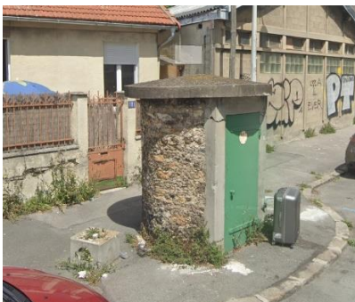
Bagnolet – Regard sur l'aqueduc de la Dhuis – 181 avenue de la Dhuis
