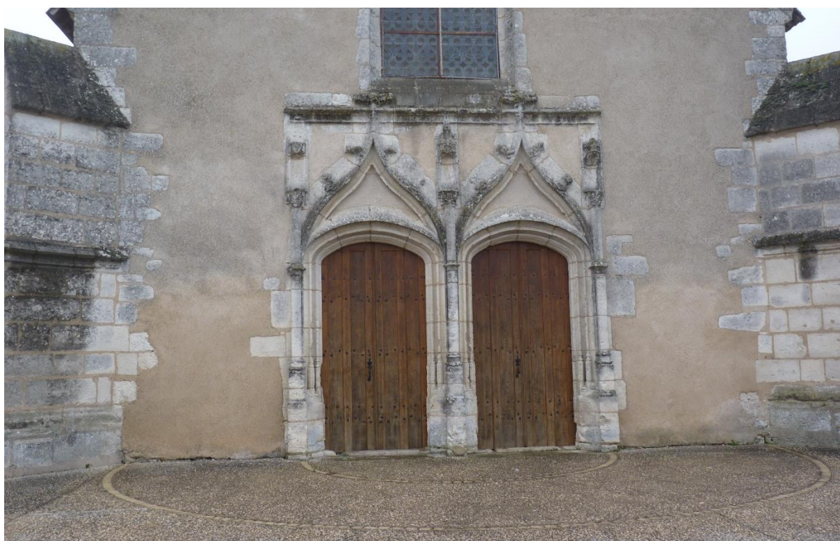
Détail de la façade Ouest : double entrée
