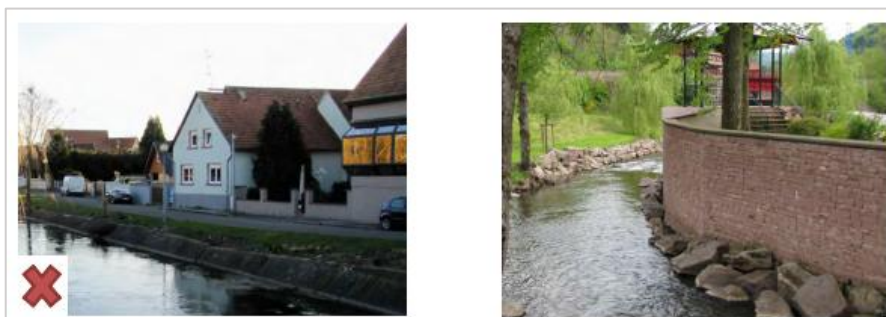
Exemple de berges fortement aménagées et imperméabilisées avec de nombreux enrochements, source : PLU de Strasbourg
