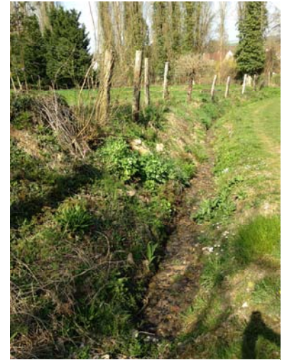
Fossé en eau à proximité du parc communal
