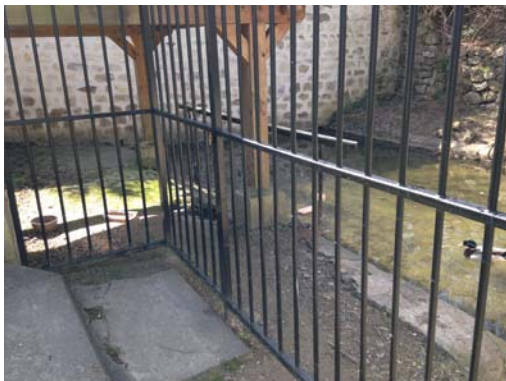
Lavoir à proximité du parc communal
