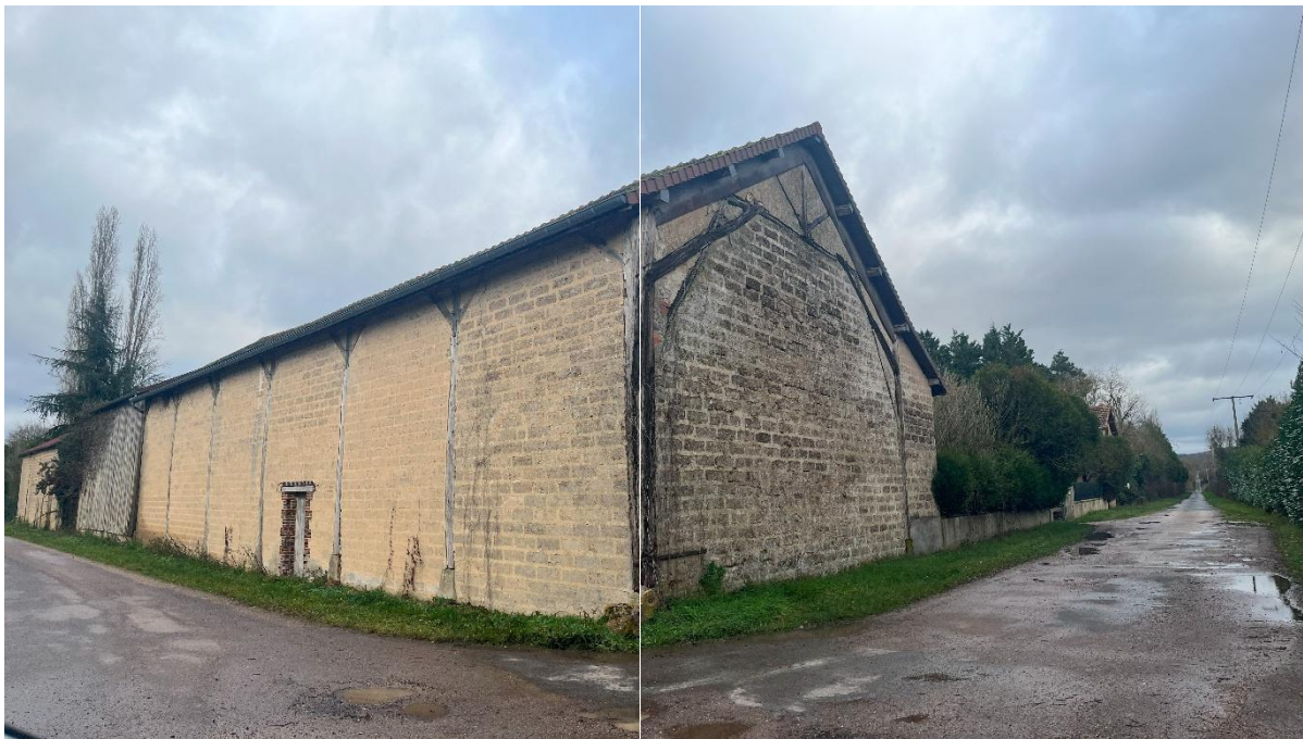
Photo 11. Terrain concerné par la modification du zonage à Passy (DBW, jan. 2025)
