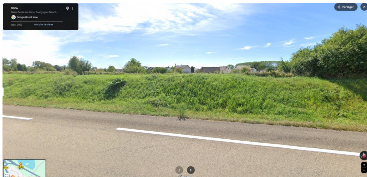
Photo 14. Merlon isolant le site n° 22 de la RD 606 (Google Street View, sept. 2023)
