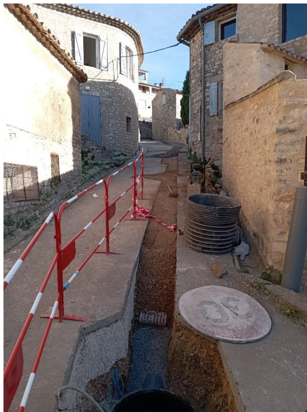
Figure n°12 : photos des travaux centre village de Murs
