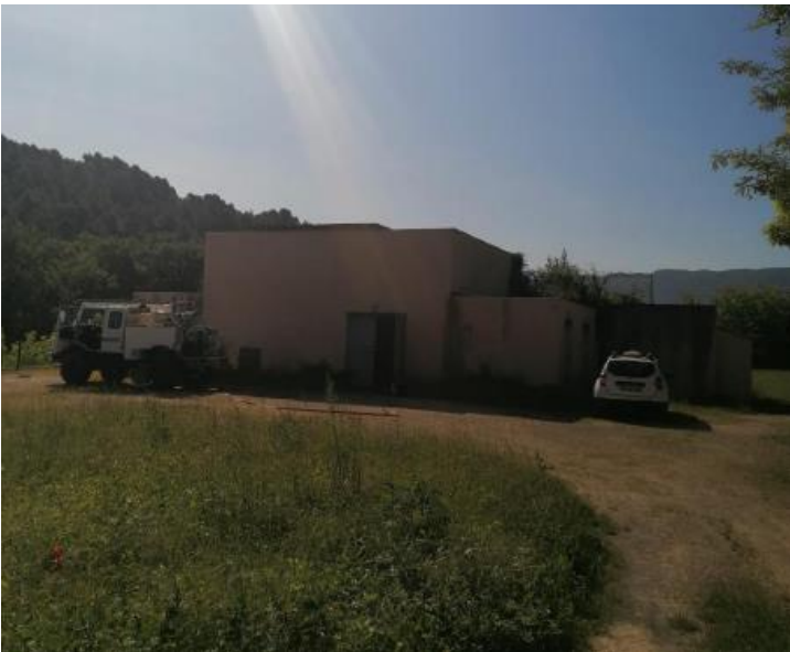
Figure n°4 : photo du site des forages du Fangas
