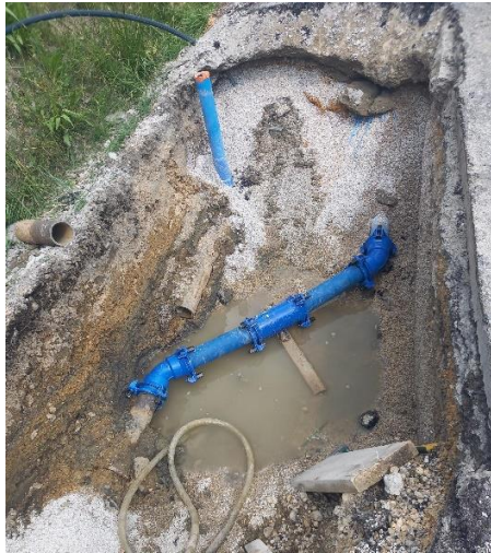
Figure n°18 : photo des travaux de renouvellement du réseau d'eau potable à Rustrel au niveau du plan d'eau
