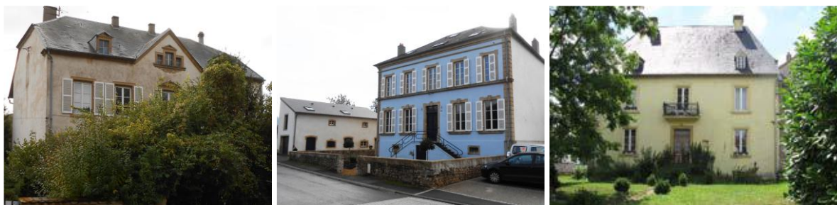
Source : Des maisons notables à Sierck-les-Bains, à Manderen, à Freistroff, CAUE
