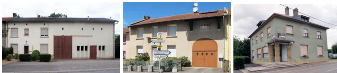
Source : Des maisons de la seconde reconstruction à Vaudreching, à Alzing et à Dalstein, CAUE
