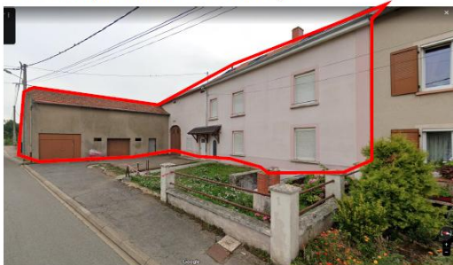
Bâtiment dans l'alignement mais à l'une des extrémités du front :
