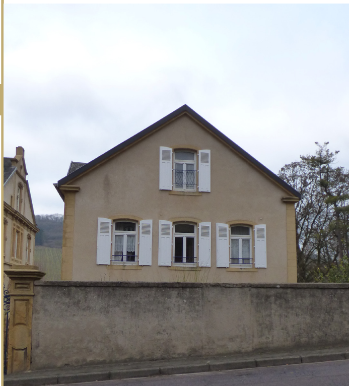
5. Façade secondaire bâtiment secondaire ouest
