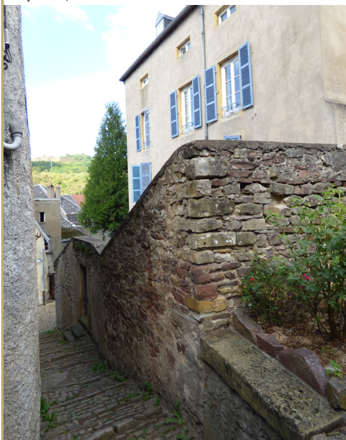
Façade 6 et accès piéton depuis la ruelle
