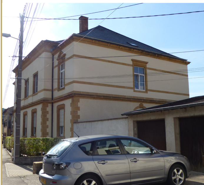
Façade secondaire latérale 2
