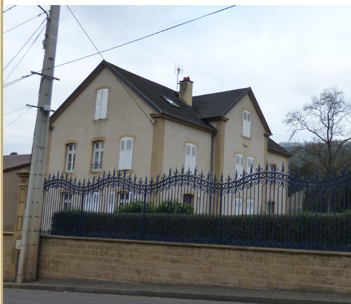
2. Façade principale bâtiment secondaire est
