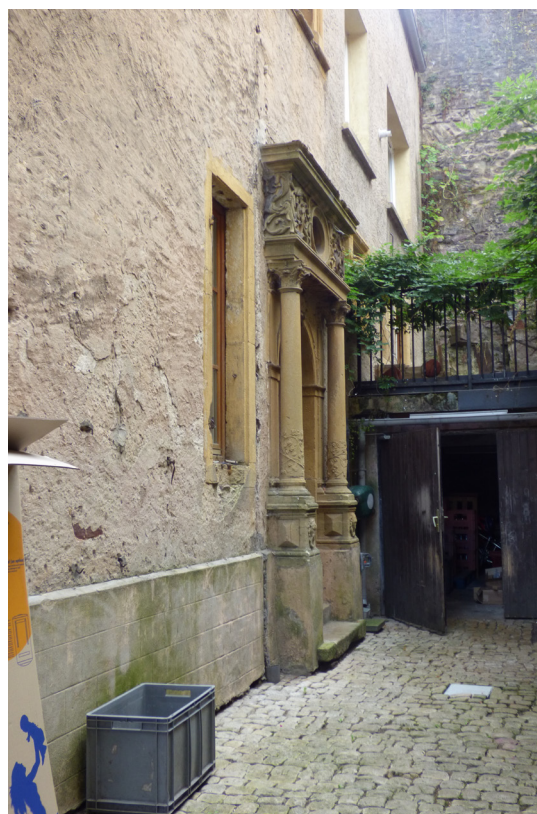
Détail porte, façade 2 latérale
