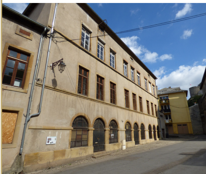
Façade 4 Rue de la Tour de l'Horloge
