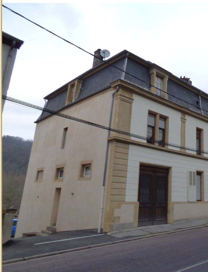
Façade secondaire latérale est 2
