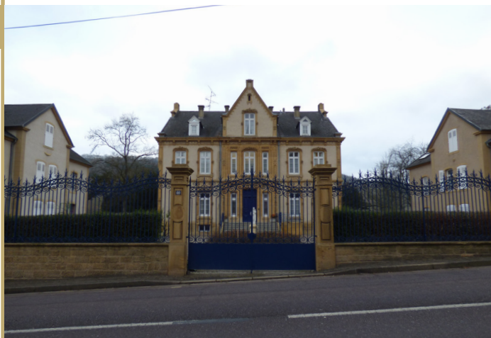
1. Façade principale maison de maître
