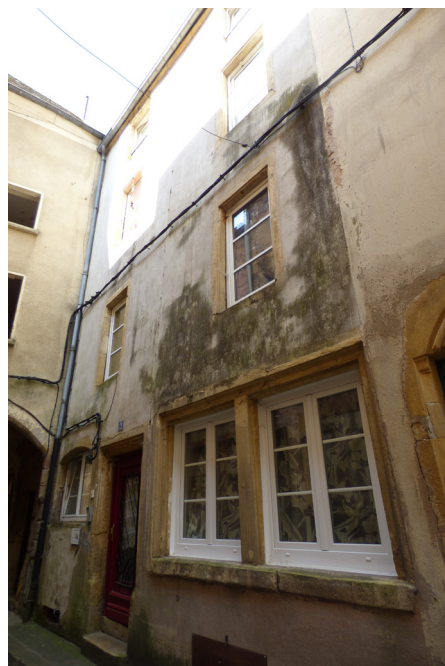
Façade principale sur la grande rue
