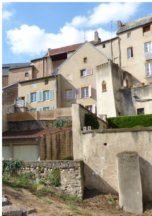
Façades remarquables 1 et 2, 4 Place Jeanne d'Arc
