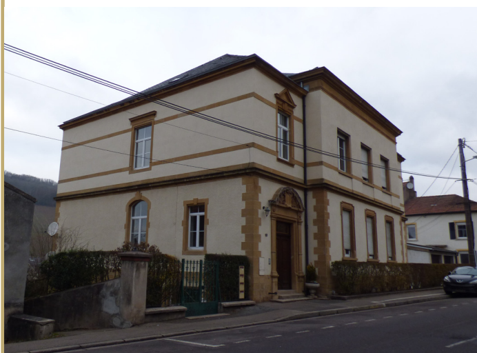
Façade secondaire latérale 3
