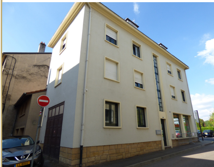
Bâtiment 2, façades 5 et 6 Grand'rue
