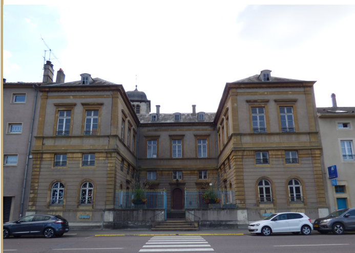
Façades 1, 2, 3 Quai des Ducs de Lorraine
