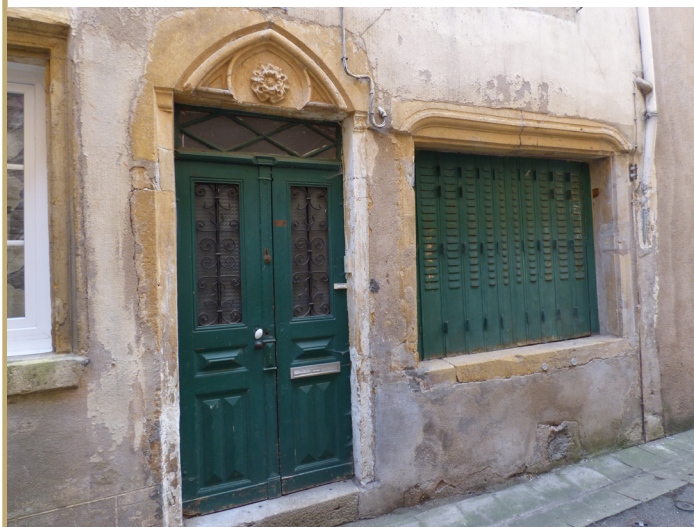
Détail porte et fenêtres façade 1
