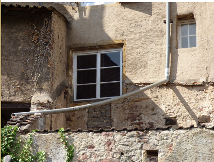
Baie anciennement à meneau, façade immeuble n°10
