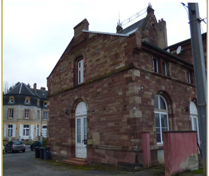
Bâtiment 1 principal- Façade 4
