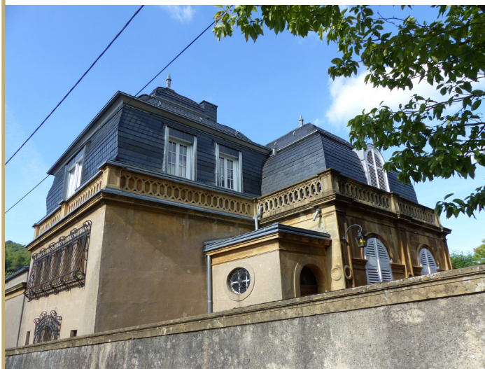
Vue depuis la rue du Docteur Fristo, façades 1 et 2
