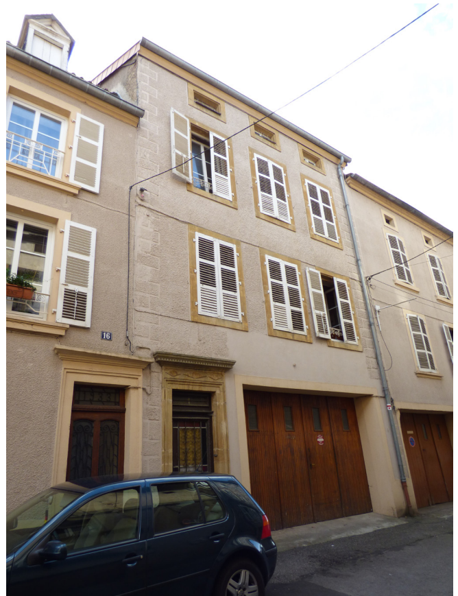
Façade 18 Rue de la Tour de l'Horloge
