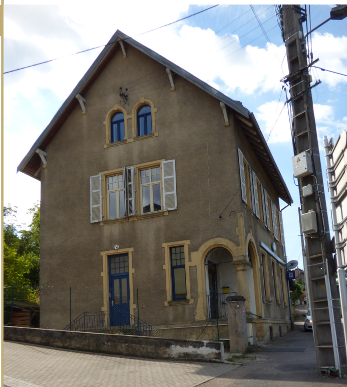
26 Rue de la Tour de l'Horloge
