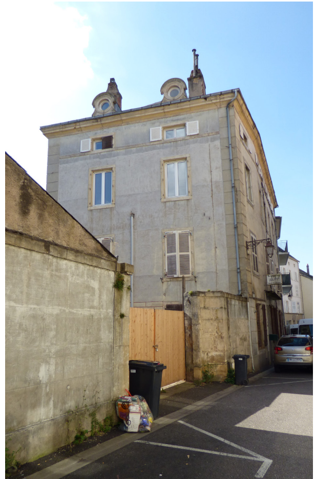
Façade 3 Rue Portes de Trèves
