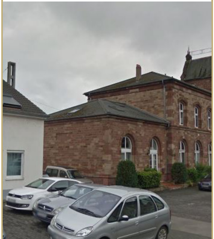
Bâtiment 1 principal- Façade 3
