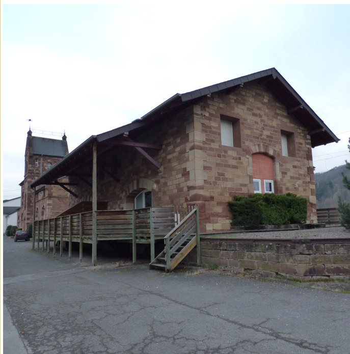
Bâtiment secondaire- Façade 9
