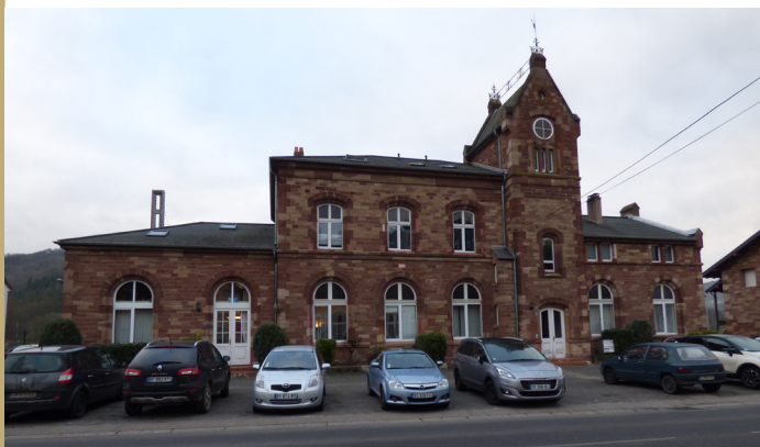
Bâtiment 1 principal- Façade 1
