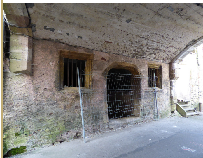
Façade 3 sous la voûte
