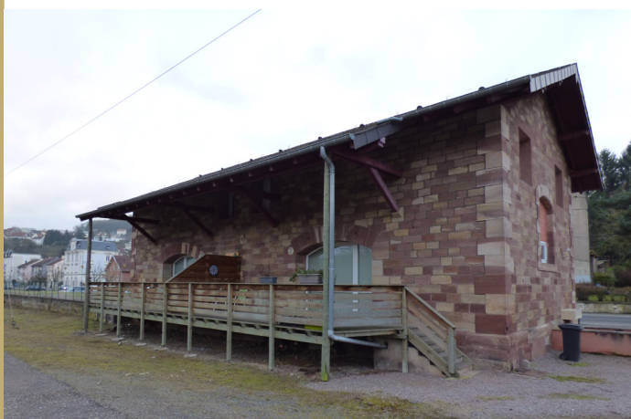
Bâtiment secondaire- Façade 7
