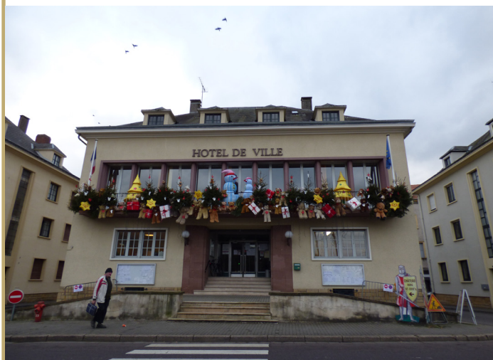
Bâtiment 1, façade 1 Quai des Ducs de Lorraine
