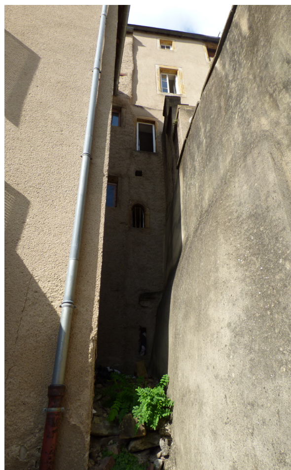
Façades 4 au niveau de l'impasse
