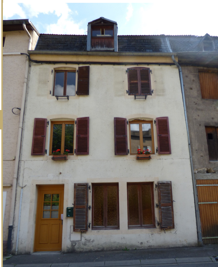
Façade, 17 Rue du Moulin
