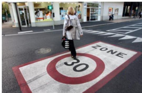
Exemple de marquage au sol avec plateau
