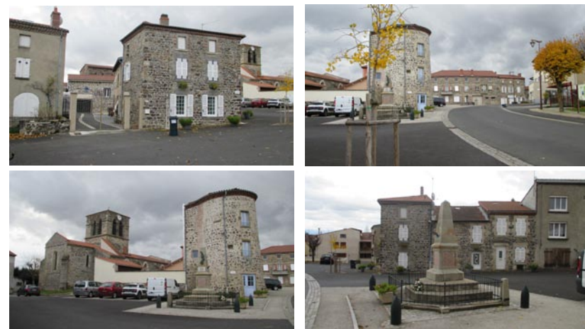
Le centre ancien de Flat classé en zone UD dans le PLUi
