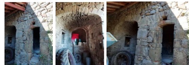
Création d'une nouvelle salle pour les séminaires
