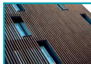
sur toiture bardeau bois
