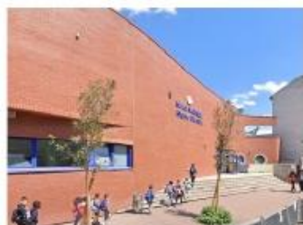
Centre nautique Auguste Delaune, Saint-Ouen
