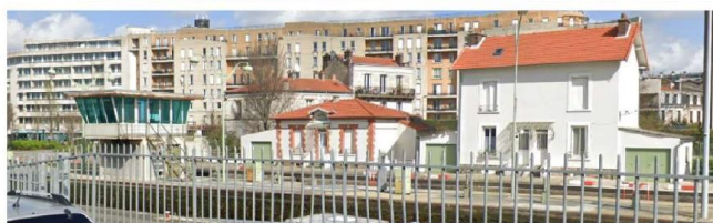
Ensemble éclusier, quai du Port, Saint-Denis
