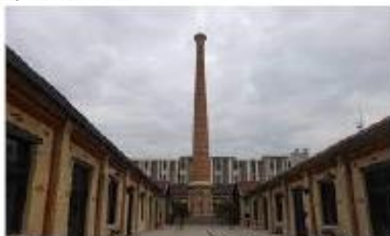
Cheminée, manufacture des allumettes, Aubervilliers
