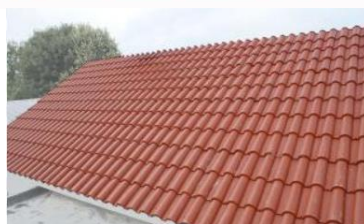
Illustration de bac acier imitant la tuile romane
