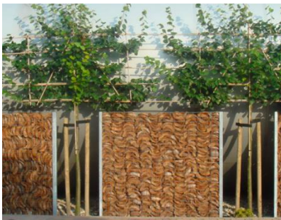
Photo illustrative de gabions remplissage bois en alternance avec du végétal
