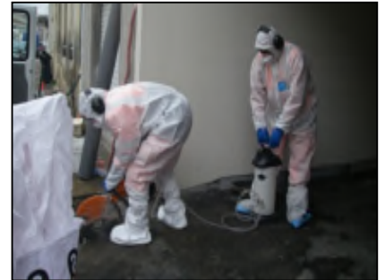
Sciage de chaussée
