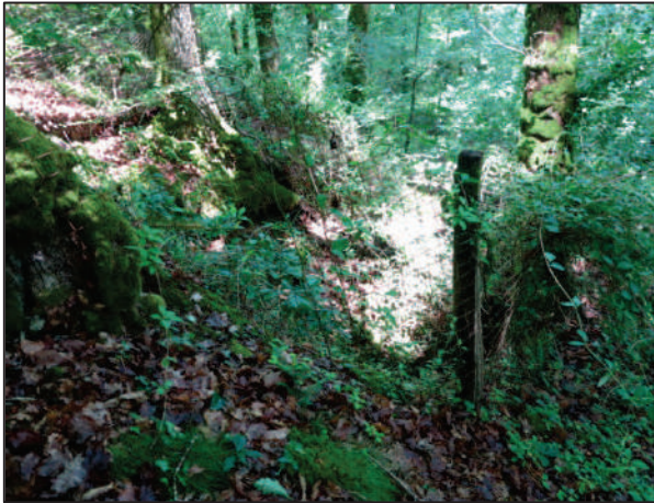
Photo 3 : Tête de la cheminée d'aérage (GEODERIS)
