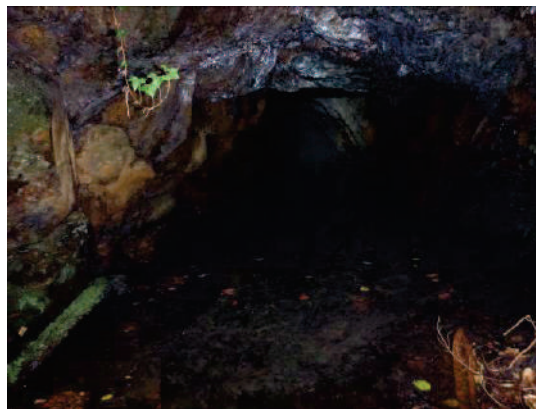
Photo 38 : Vue de l'intérieur du travers-banc Ouest ennoyé
