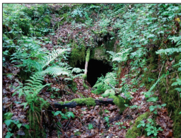
Photo 1 : Entrée du travers-banc (GEODERIS)
