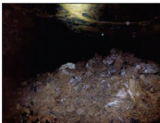
Photo 42 : Remontée de voûte
