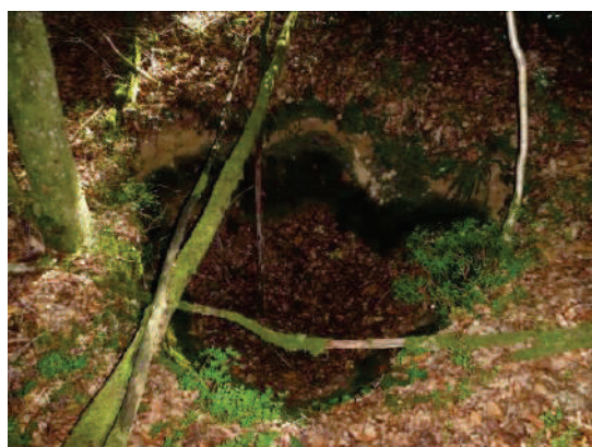
Photo 16 : Fontis Puits de Recherche N°13 de Doumont
