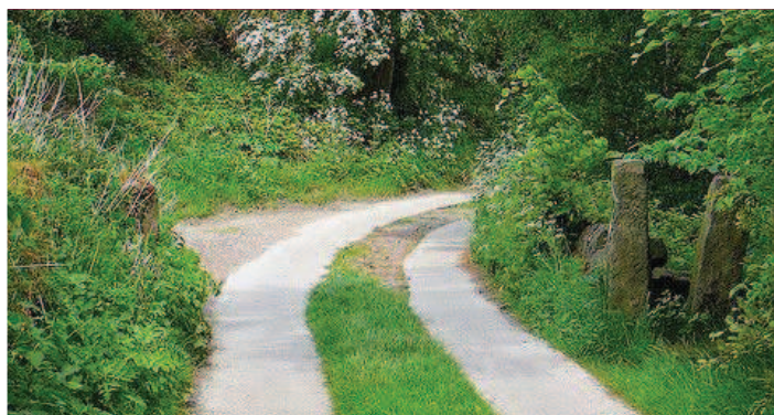
Exemple d'aménagement de chemin rural, carrossable.
