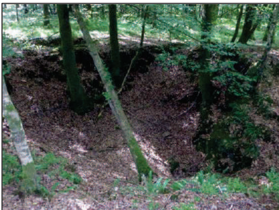
Photo 3 : Fontis Descenderie N°3 de Berdallier
