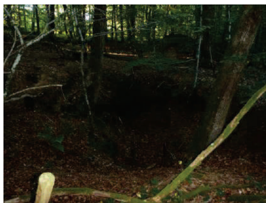
Photo 47 : Fontis Puits N°3 du Haut-Fiché
