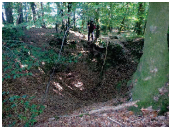
Photo 18 : Fontis Puits de Recherche N°16 de Doumont
