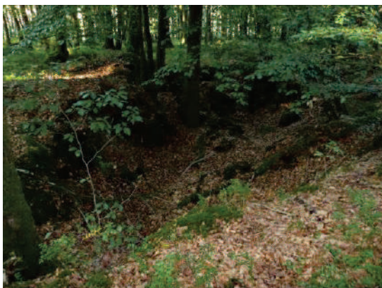
Photo 11 : Fontis travers-bancs N°1 de Doumont
