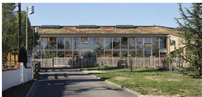
Toiture végétalisée. Ecole l'ISLE D'ESPAGNAC.
