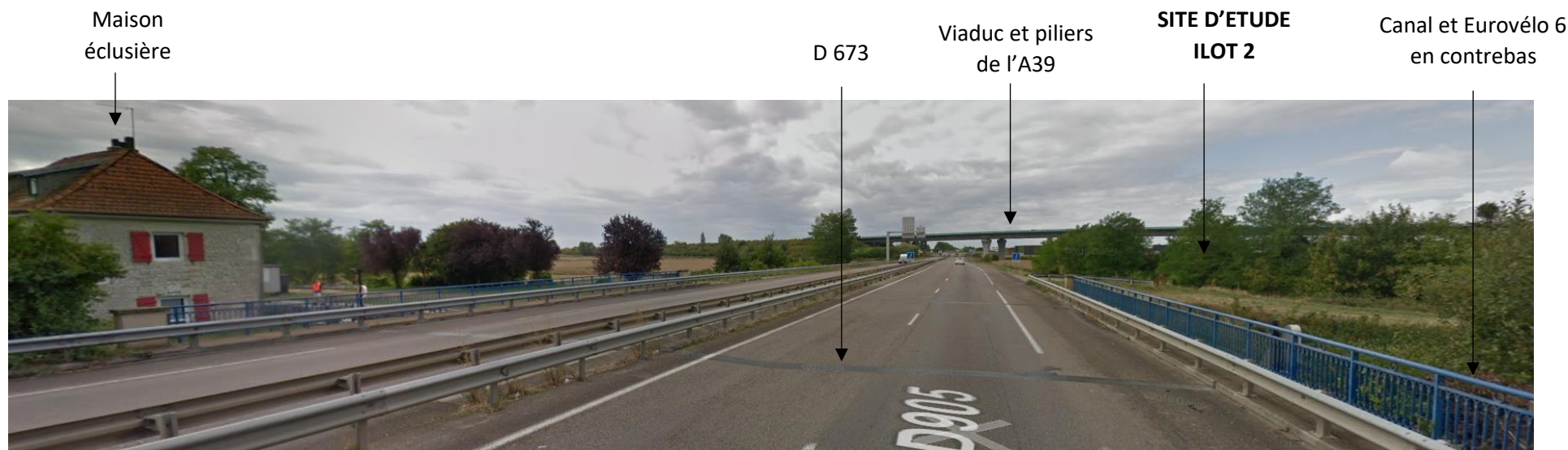
Vues 1, 2 et 6/ D 673 - Vue vers le Nord-Est
