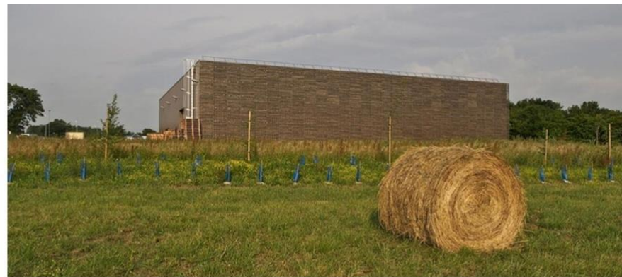
Volume simple et bois, Hôtel d'entreprise, Puceul, GLV architecture
