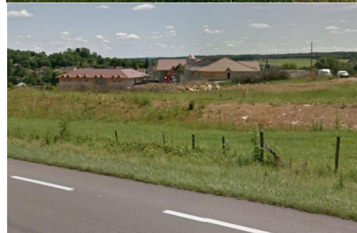
Résidence de Courcelles, EHPAD, Rochefort-sur-Nenon
