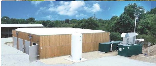
Exemple de site de méthanisation/biogaz
