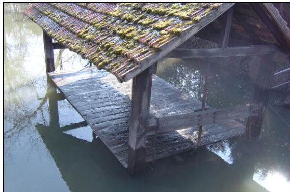
Photos du lavoir à niveau de SAND
