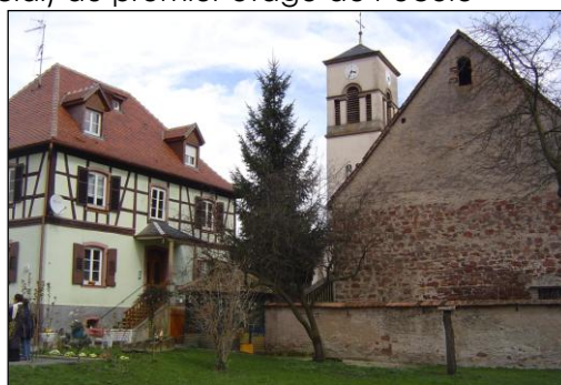
Photo du presbytère rénové
