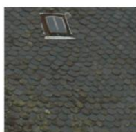
Ardoise corrézienne taillée en écailles, Marcillac-la-Croisille
