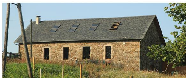
Le percement de fenêtres de toits, suivant la trame existantes valorise le volume global de la grange, Moustier-Ventadour
