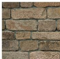
Granite, appareillage réglé, Saint-Yrieix-le-Déjalat
