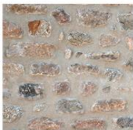
Granite, appareillage réglé, Darnets
