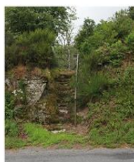
Escalier en roche massive, Péret-Bel-Air
