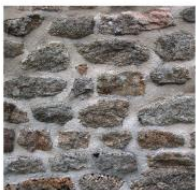
Granite, appareillage réglé, Péret-Bel-air
