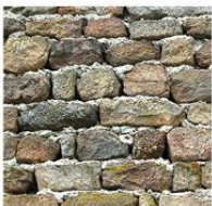
Granite, appareillage réglé, Rosiers d'Egletons
