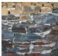
Schiste, appareillage mixte, Laval-sur-Luzège
