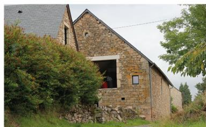
Une large baie permet de profiter du paysage, Marcillac-la-Croisille
