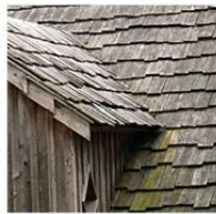
Bardeaux de Châtaigniers, Meyrignac-l'Eglise
