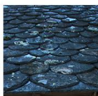
Ardoise corrézienne taillée en écailles, Laval-sur-Luzège
