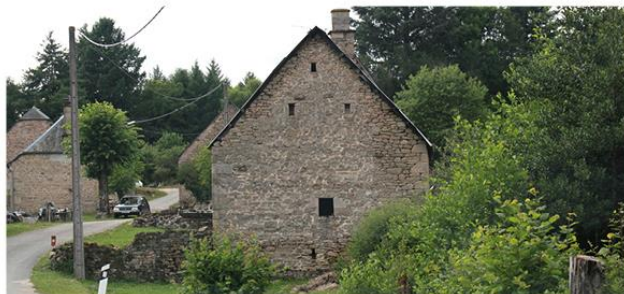
Jeu de soutènement avec pignon, St-Yrieix-le-déjalat
