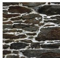
Schiste, appareillage mixte, Saint-Yrieix-le-Déjalat
