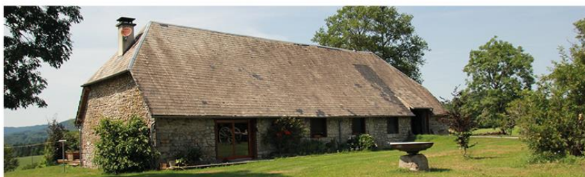
De nouvelles menuiseries en bois mettent en valeur les ouvertures de la Grange, commune de Darnets
