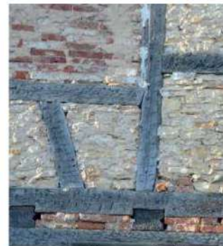
Maçonnerie et briques
