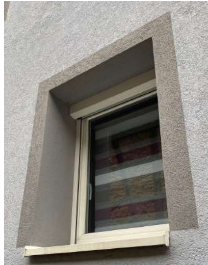
Isolation Thermique par l'extérieur. (Bouxwiller)
