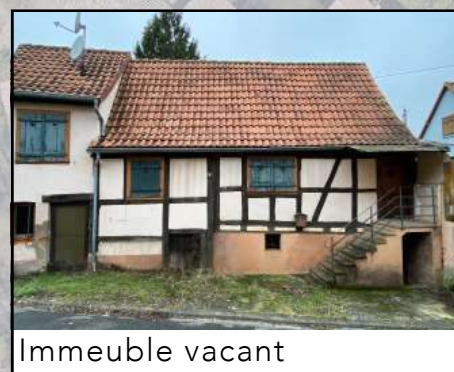
Immeuble abandonné et dégradé de l'Impasse Koch
