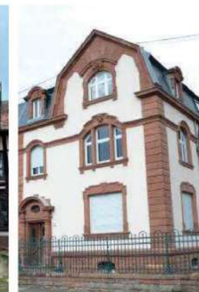
Façade en maçonnerie, pierre de taille et enduit
