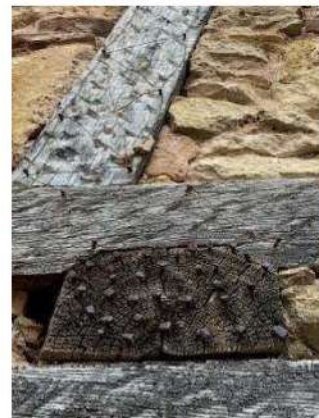
Clous pour fixation des enduits au XIXe siècle
