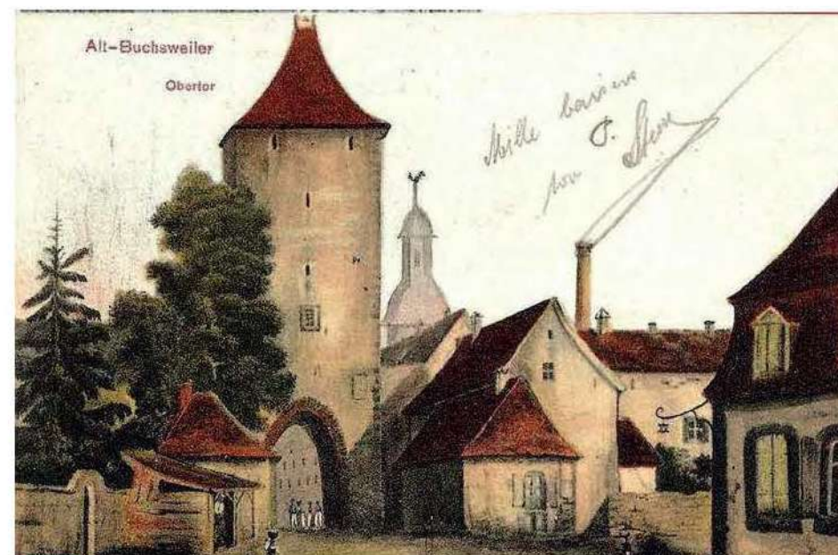
Porte d'entrée Nord, vue depuis l'extérieur de la ville
