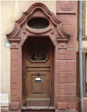
★7. Encadrement et porte remarquable de 1909
