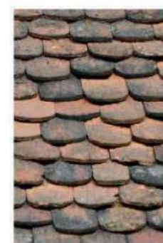
couverture en tuiles plates
