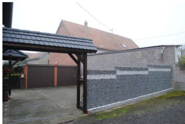
Clôture occultante en gabion.
