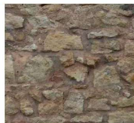
Maçonnerie en calcaire, prévue pour être enduite
