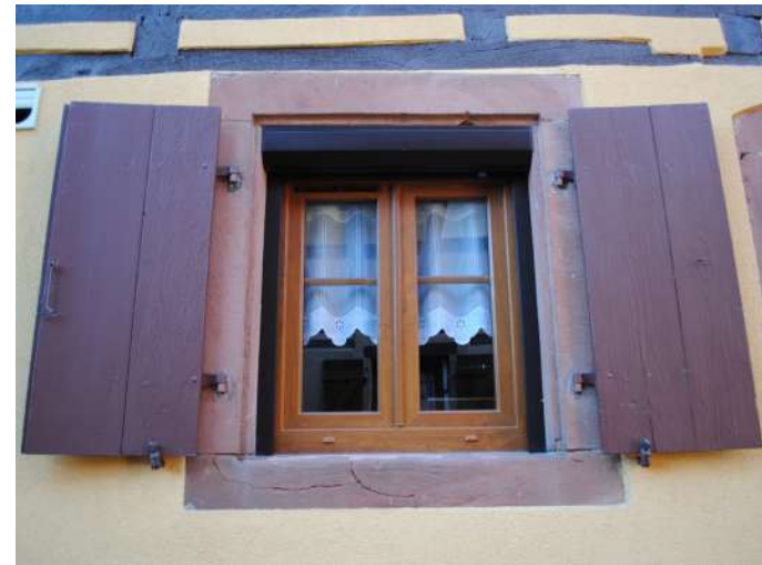
Volet roulant avec caisson apparent et menuiserie PVC aspect bois.
