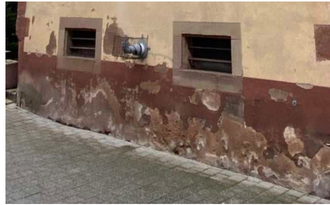
Imperméabilisation trop importante : revêtements pavés en béton favorisant les remontés d'humidité dans les maçonneries et les enduits. (Bouxwiller)
