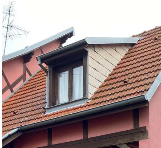
Lucarnes et chassis de toit. Matériaux et dimensions inadaptés. (Bouxwiller)
