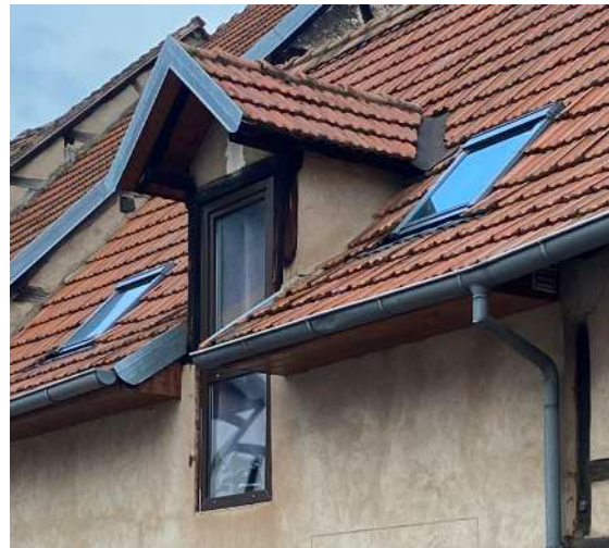
Lucarnes et chassis de toit. Matériaux et dimensions inadaptés. (Bouxwiller)
