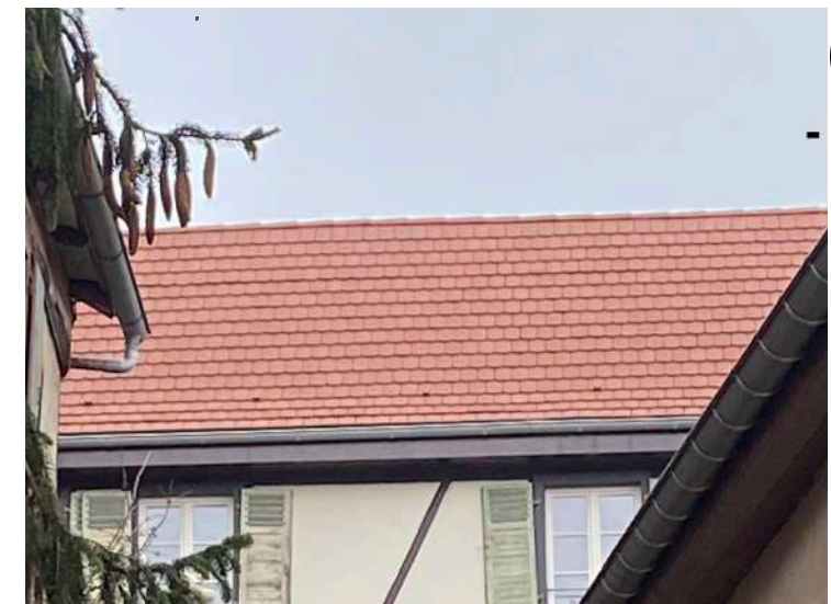
Tuiles à emboîtement «aspect écaille».
