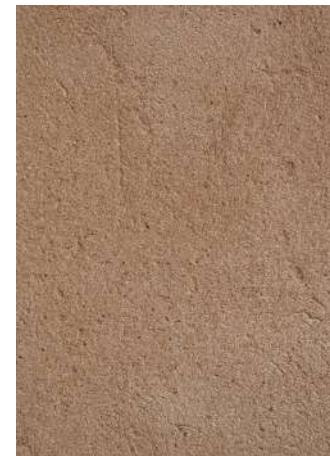
Enduit à la chaux et sable rouge.
