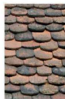
couverture en tuiles plates
