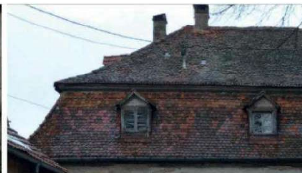
toiture mansardée avec lucarnes
