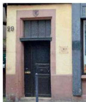
RDC/soubassement en grès
