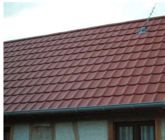
Tuiles mécaniques neuves au relief insuffisant.
