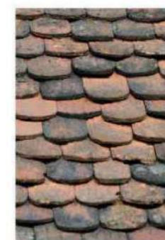
couverture en tuiles plates
