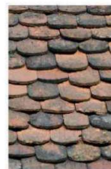
couverture en tuiles plates
