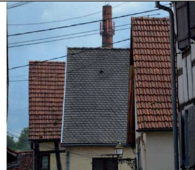
Tuiles plates et tuiles mécaniques
