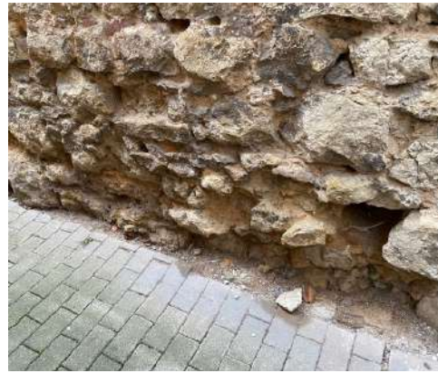
Imperméabilisation trop importante : revêtements pavés en béton favorisant les remontés d'humidité dans les maçonneries et les enduits. (Bouxwiller)
