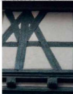
pans de bois et enduit
