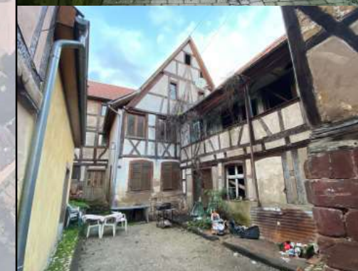
Impasse Nestel : forte densité bâtie
