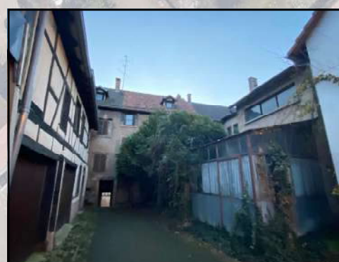
Immeuble vacant au 58 et 60 Grand'Rue
