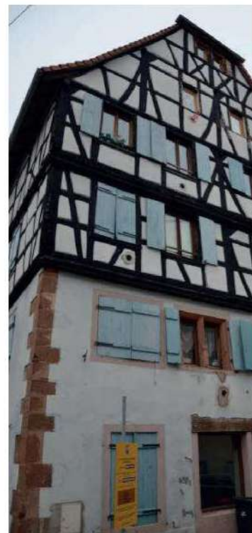
Façade mixte, avec chaîne d'angle en grès
