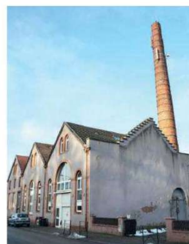
Bâtiments de l'administration des mines
