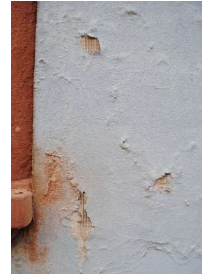
Enduit plastique sur filet.
