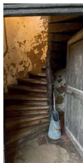
Escalier à vis en bois
