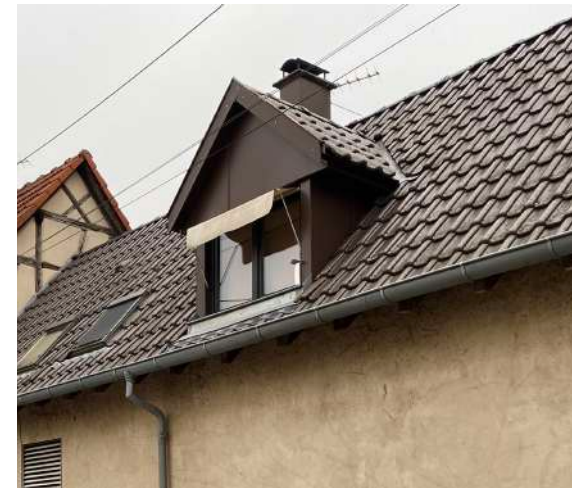
Couverture en tuiles mécaniques noires et lucarnes aux matériaux et dimensions inadaptés. (Bouxwiller)
