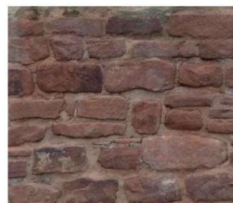
Maçonnerie en grès des Vosges, prévue pour être enduite
