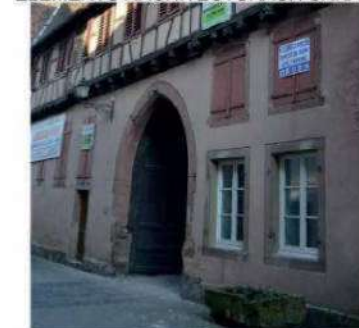
Rdc et entresol en grès - grande porte cochère
