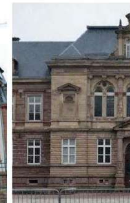
Façade en pierre de taille
