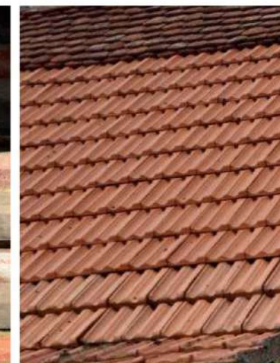
Tuiles mécaniques
