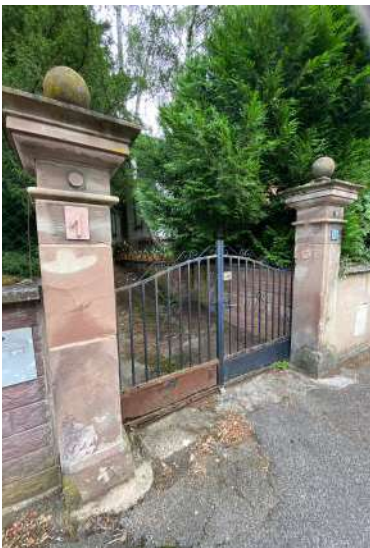
J2. Portail d'une maison de Maître
