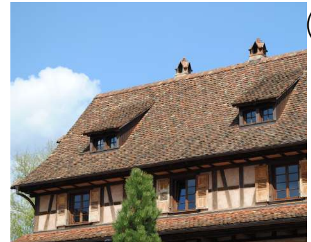
Couverture en tuiles plates de récupération et lucarnes aux matériaux et dimensions adaptés.
