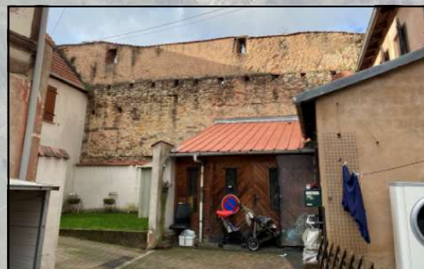
Bâtiment annexe ne s'intégrant pas au tissu bâti ancien
