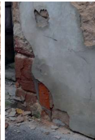
Soubassement enduit au ciment favorisant les remontées d'humidité et de sels. (Bouxwiller)
