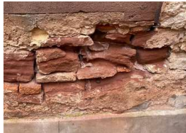
Soubassement enduit au ciment favorisant les remontées d'humidité et de sels. (Bouxwiller)
