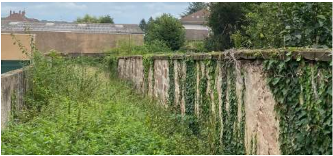
B2. Venelle piétonne et mur en grès
