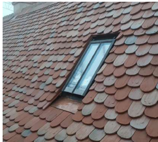
Châssis de toit de type tabatière encastré dans la couverture.
