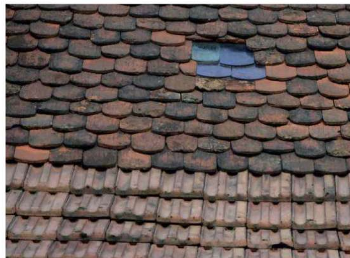
Tuiles plates artisanales et tuiles mécaniques
