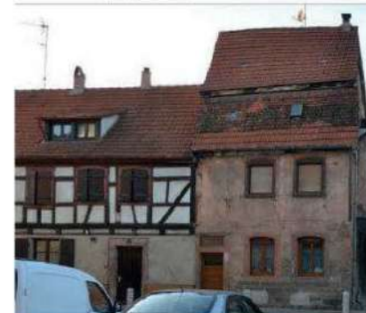
Maison de faubourg à l'alignement de la rue
