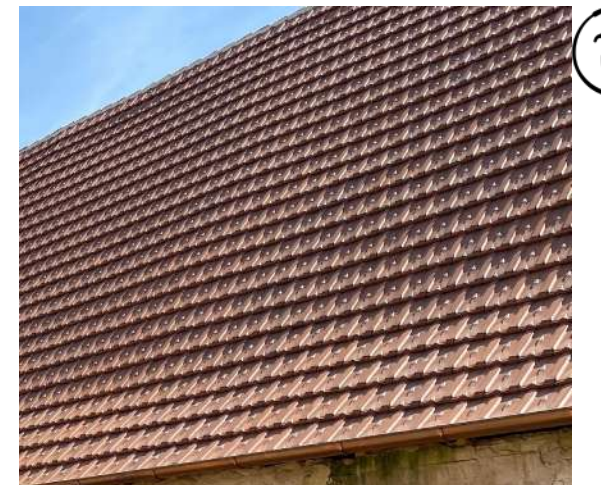
Tuiles mécaniques neuves avec suffisamment de relief. (Bouxwiller)
