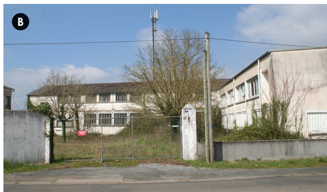
Vue depuis l'Est, rue Daniel Archaimbault.
