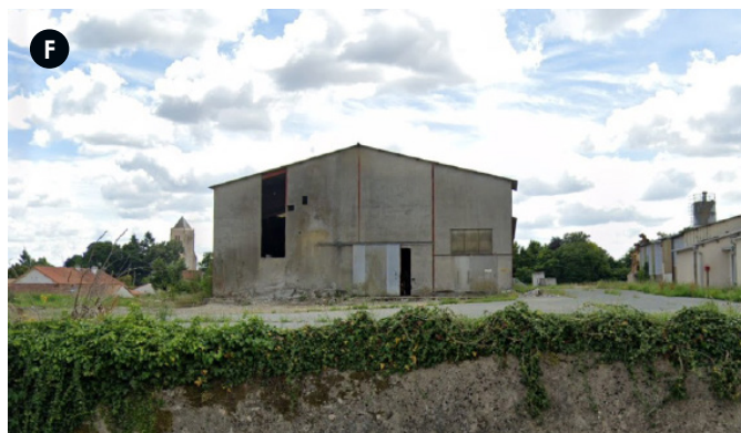
Vue depuis le Nord, rue Daniel Archaimbault.
