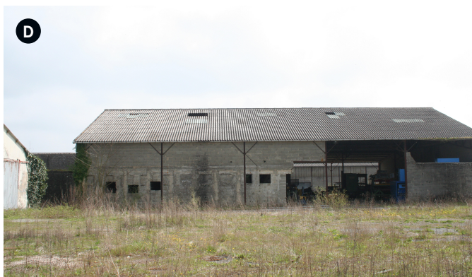
Vue depuis l'Ouest, rue Daniel Archaimbault.
