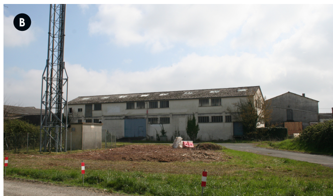
Vue depuis l'Ouest, arrière du bâtiment
