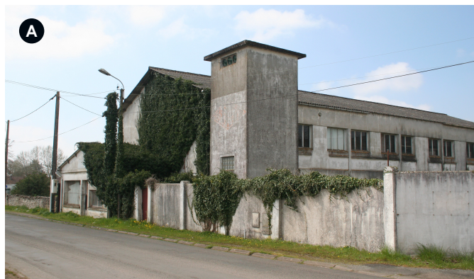
Vue depuis l'Est, rue Daniel Archaimbault.
