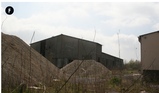
Vue depuis le Nord, rue Daniel Archaimbault.
