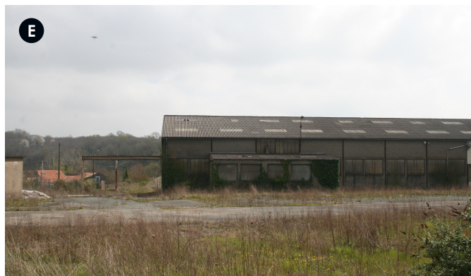
Vue depuis l'Ouest, rue Daniel Archaimbault.
