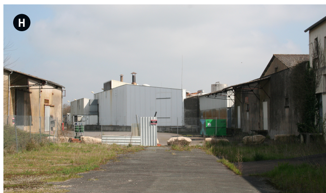
Vue depuis l'Est, rue Daniel Archaimbault.
