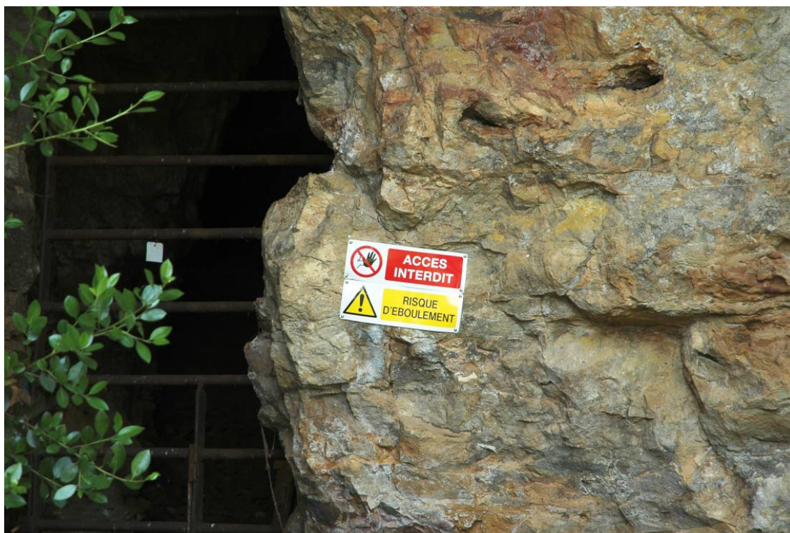
Photo 33 - L'Araignée : panneau de danger.
