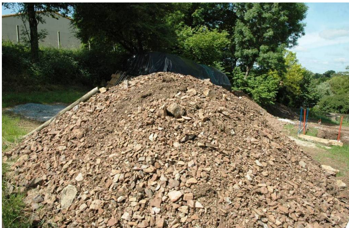
Photo 24 - Idem photo 22 (les éclats de creusement au feu ont été mis en tas après le creusement des fondations d'un pavillon).
