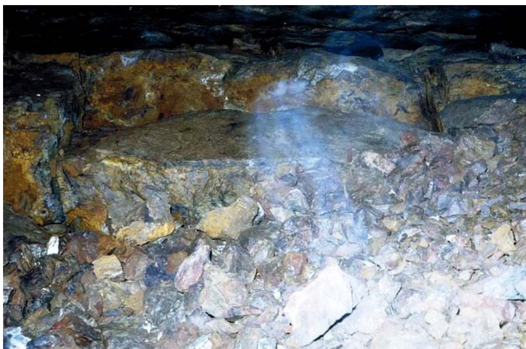
Photo 8 - Vue d'une dalle de faux toit décollée et tombée au sol dans le réseau TDF, et les déblais (Tereygeol, 2001).
