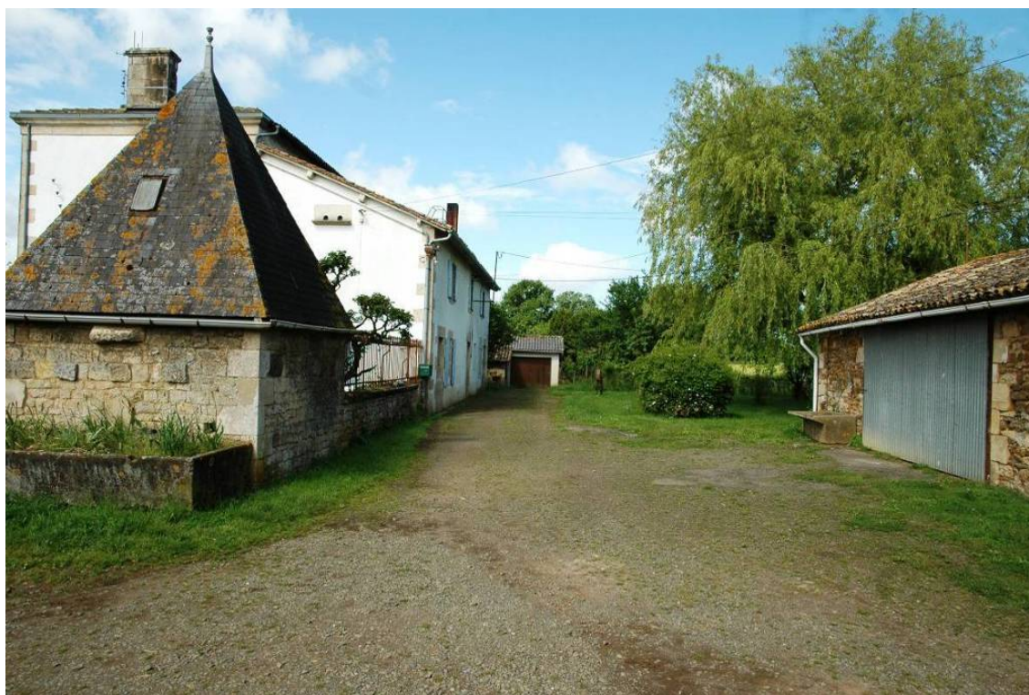
Photo 49 - Ferme du Haut Tublier avec, à droite, le garage dont les murs sont fissurés et, à gauche, le clocheton du Puits P29.
