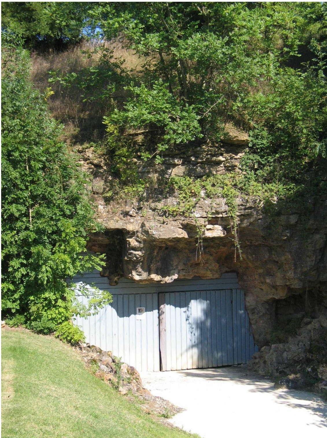
Photo 28 - Travaux de la Noblette : porte d'entrée de la galerie G2 (entrée du circuit touristique) ; photo INERIS.
