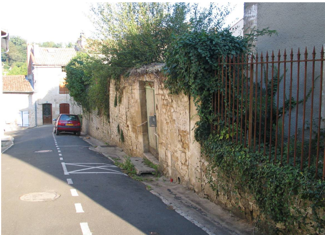
Photo 42 - Travaux P2 de la maison Decemme : le mur basculé autour du jardin et à son pied (au-delà du portail en bois) la plaque en fer cadénassée qui sert d'entrée au réseau souterrain.
