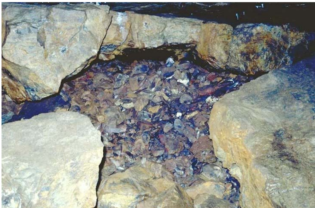
Photo 7 - Lucarne d'effondrement dans le plafond d'une chambre inférieure du réseau TDF montrant son remblaiement complet après l'effondrement (Tereygeol, 2001).
