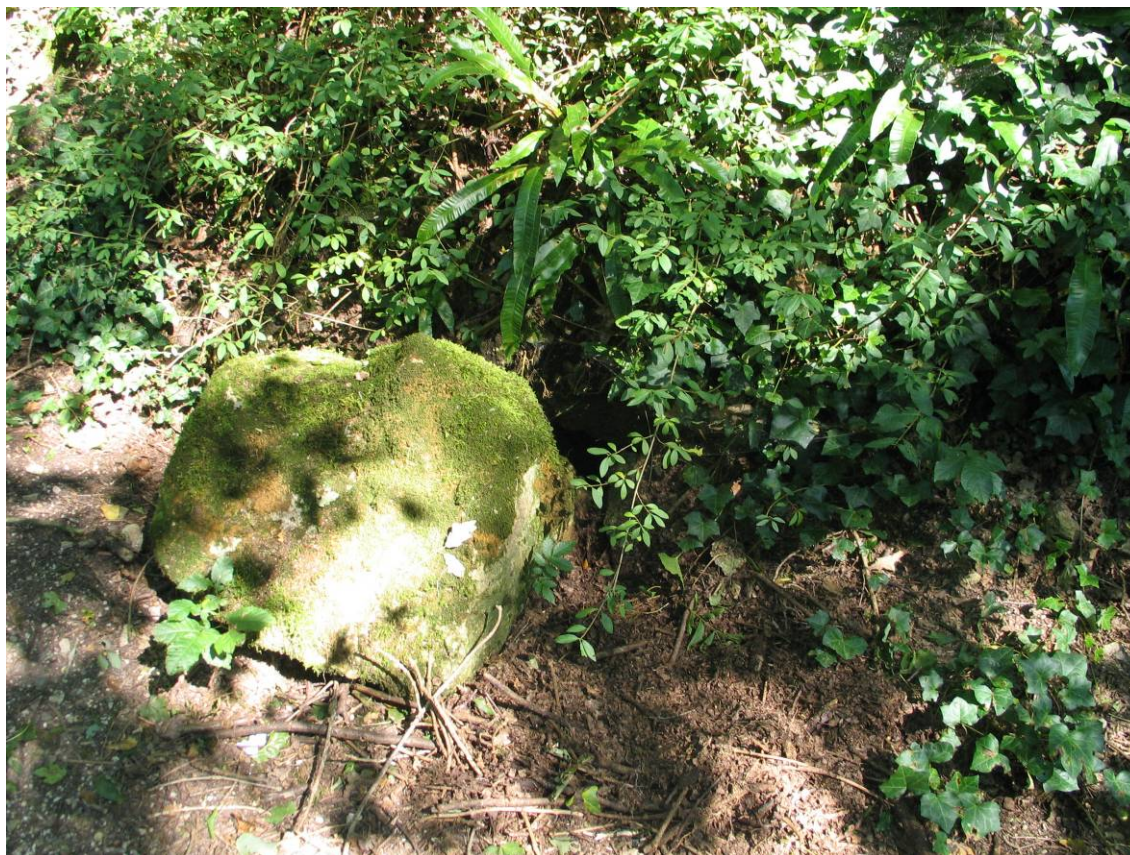
Photo 35 - Travaux du Serpent (P1) : vue de détail de l'entrée (photo INERIS).
