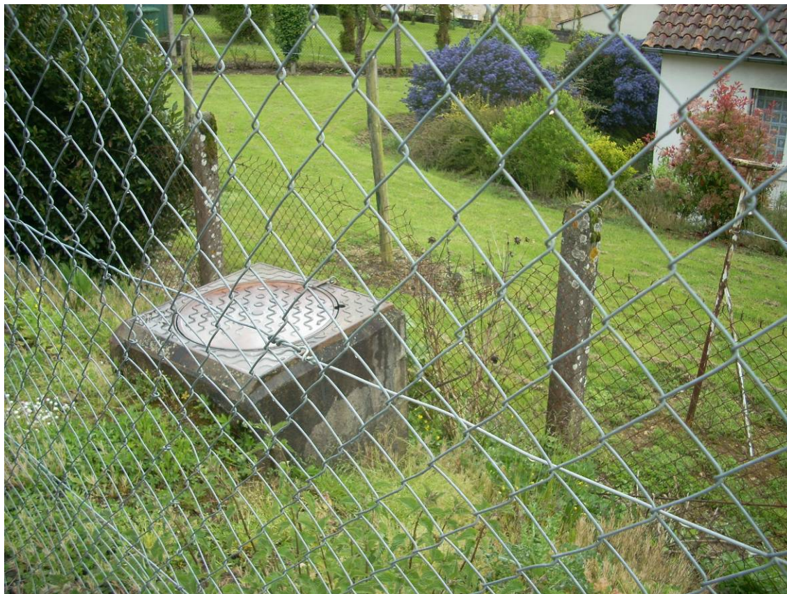
Photo 45 - Entrée des travaux du réseau T.D.F. (P3).
