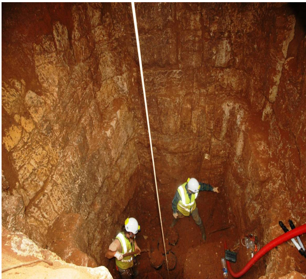
Photo 11 - Un des puits de la photo 10 en cours de déblaiement (calcaires du Bajocien).
