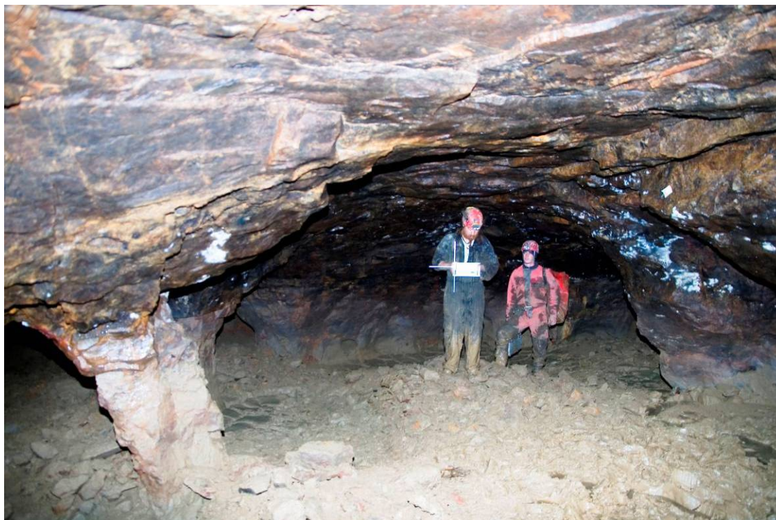
Photo 6 - Chambre non remblayée dans le réseau TDF (Tereygeol, 2001).
