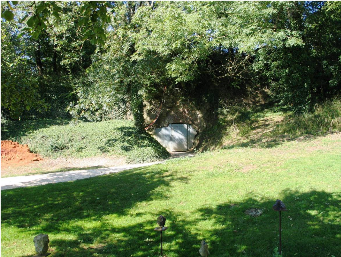
Photo 29 - La Noblette : porte d'entrée de la galerie G3 (sortie du circuit touristique) ; photo INERIS.
