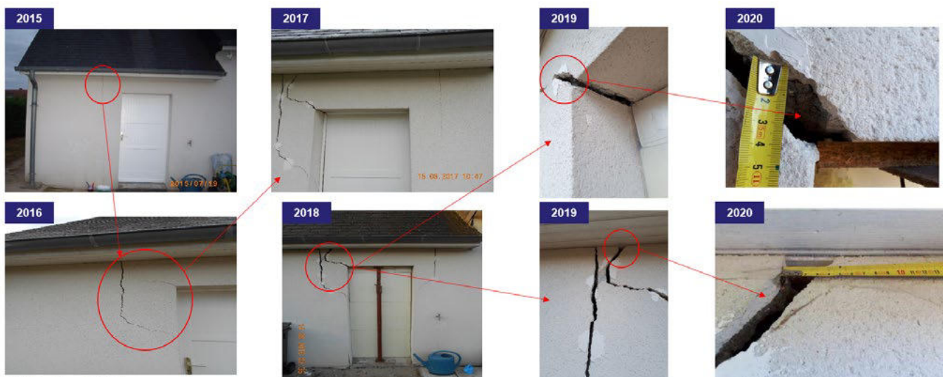
Figure 7 : Aggravation de la fissuration d'une maison sous l'effet des sécheresses de 2015 à 2020.
