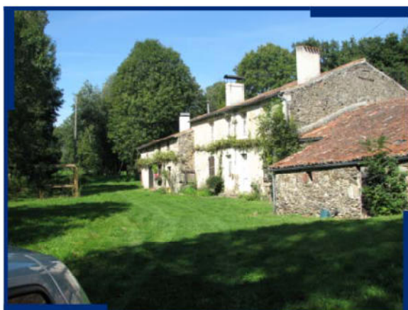
10. "Petite Lunardière" : l'eau est montée il y a une trentaine d'années au niveau du seuil de la porte.
