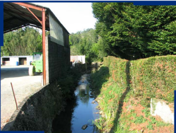
3. "Pamplie" : Vue sur le lit mineur de la Miochette vers l'amont. Le hangar en rive droite est construit en remblai
