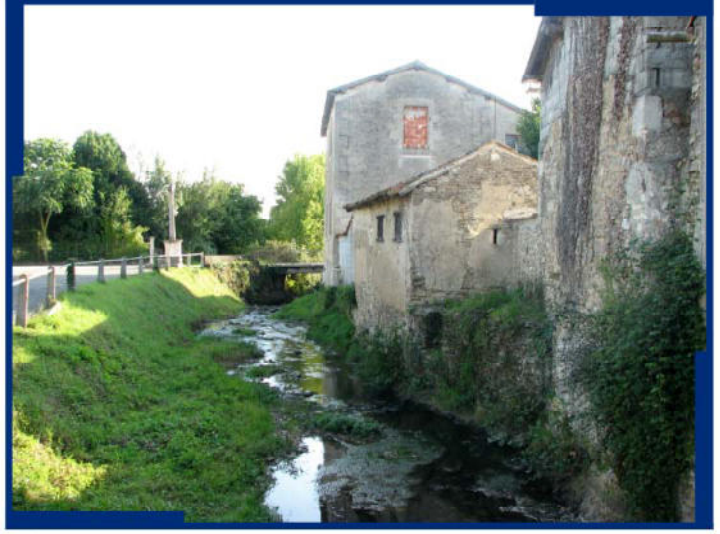
6. "Pamplie" : Vue sur le lit mineur de la Miochette vers l'aval. On observe des bâtiments en rive droite inondables mais inhabités.
