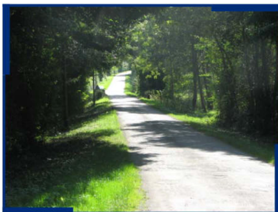
12. "La Vergnée" : vue sur la route en remblai qui traverse la plaine alluviale.
