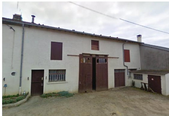
Fermes-blocs à Longchamp et Sommerécourt (Source : Google Maps)
