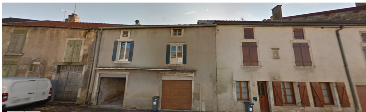
Maison mitoyenne ancienne à Andelot-Blancheville (Source : Google Maps)
