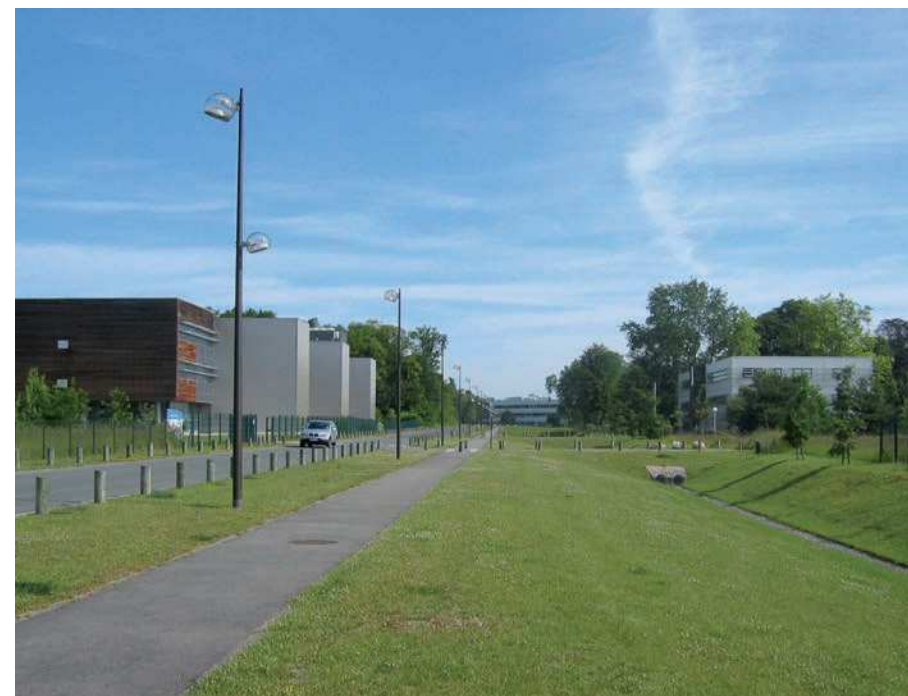
Une noue au Parc Orléans-Charbonnière
