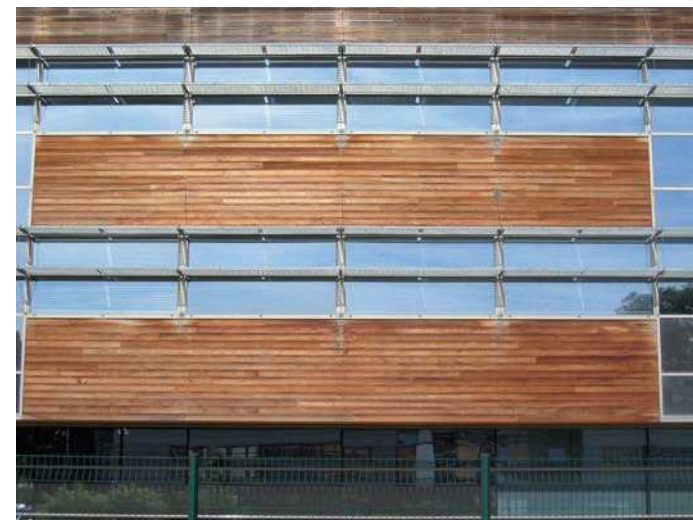
Façade bois Orléans-Charbonnière
