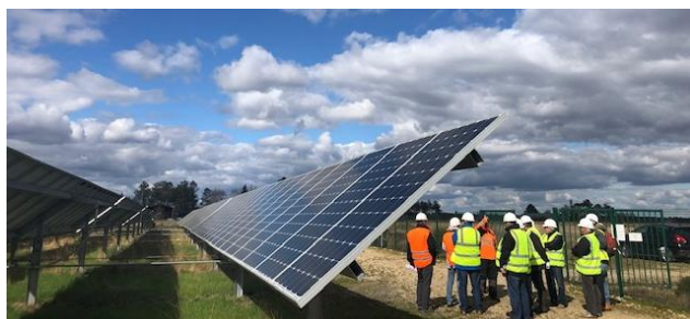
Visite d'une centrale photovoltaïque à Luxey
