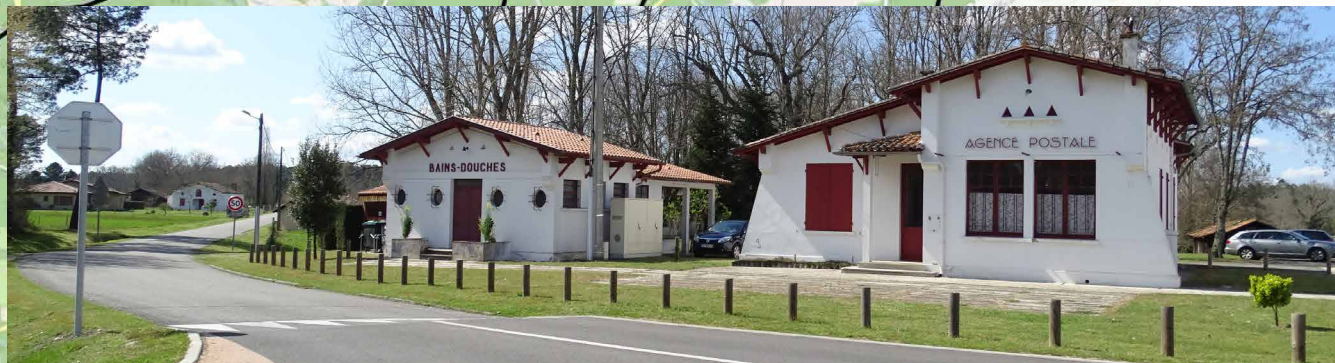
Un triptyque de bâtiments construits entre 1949 et 1959, à proximité de l'église classée monument historique, structure le bourg aéré de la commune
