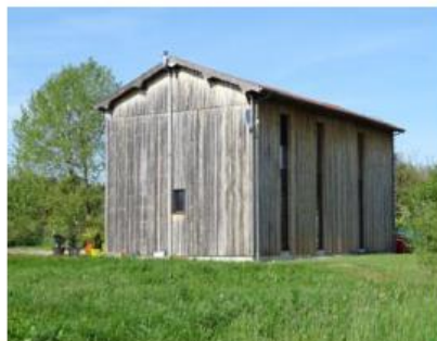
Séchoir réhabilité à Caussignac
