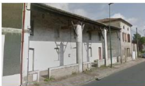
Maison à galerie à Captieux
