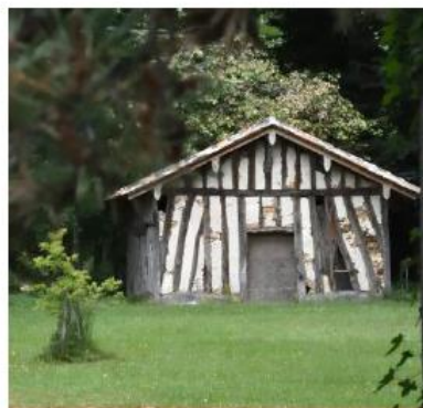
Remise à Lartigue
