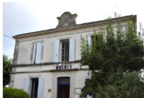
Mairie de Cours-les-Bains
