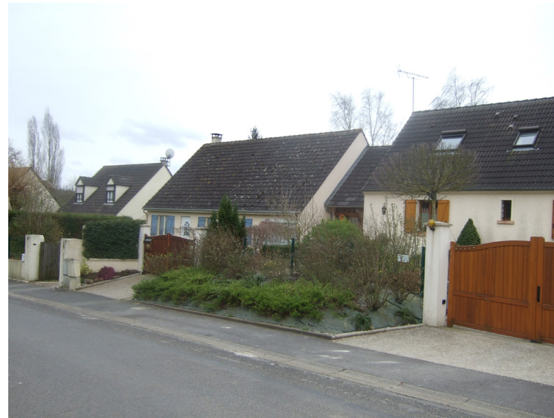
Bas côtés aménagés rue de la Halte permettant le stationnement.
