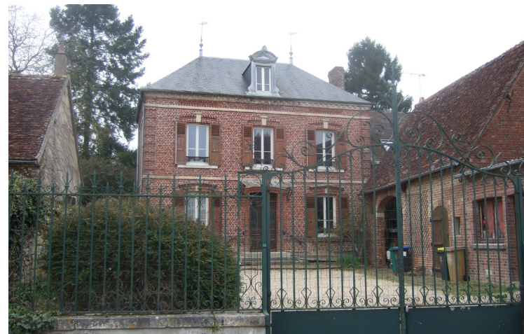
Construction ancienne de briques rouges et de pierre en retrait de la rue
