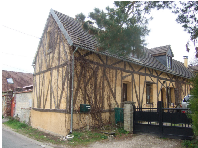
Construction ancienne à colombage
