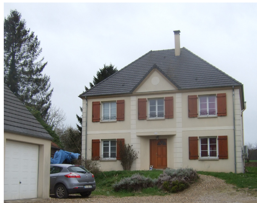
Construction pavillonnaire récente imitant le style de la pierre et annexe isolée.
