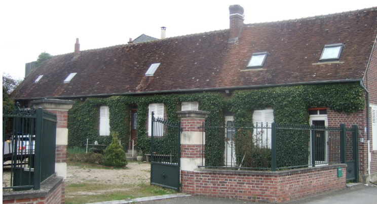
Construction en brique avec pignon sur rue
