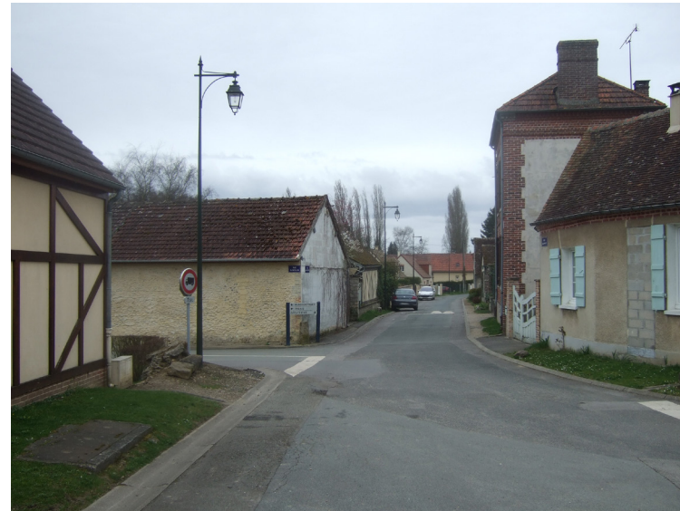
Mélange de typologie du bâti ancien rue Fresnes, mêlant colombages, silex, briques et pierres blanches
