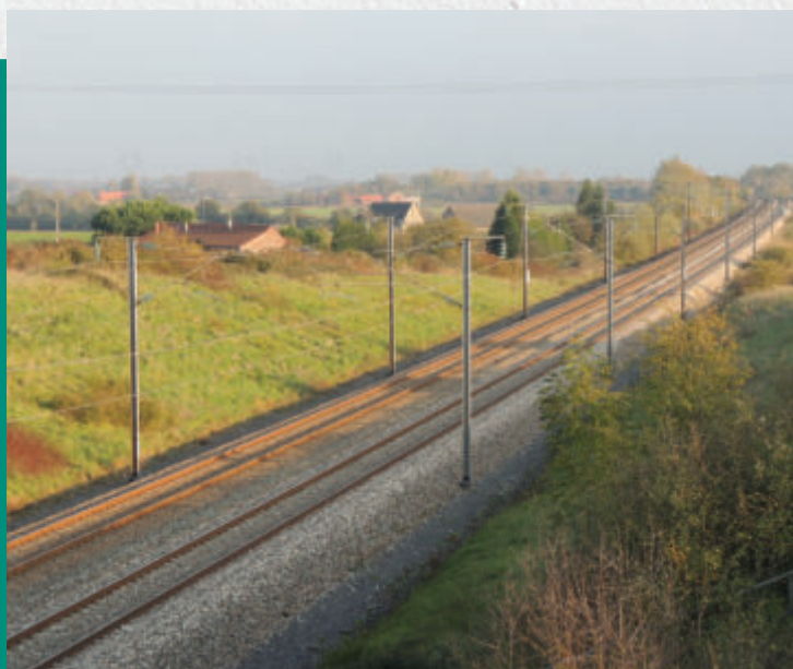
©M.TOUSSAINT (CCFI) - Voie ferrée à Bailleul
