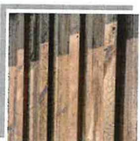
Assemblage à la landaise, Pointes Inox
