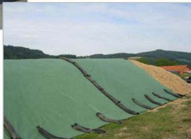
Protection de zones de stockage des matériaux
